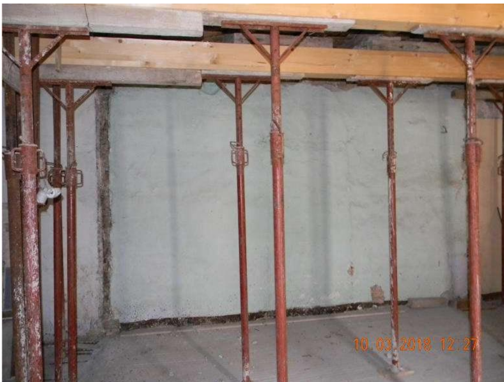
Foto 10 - Scorcio della parete ovest del vano
