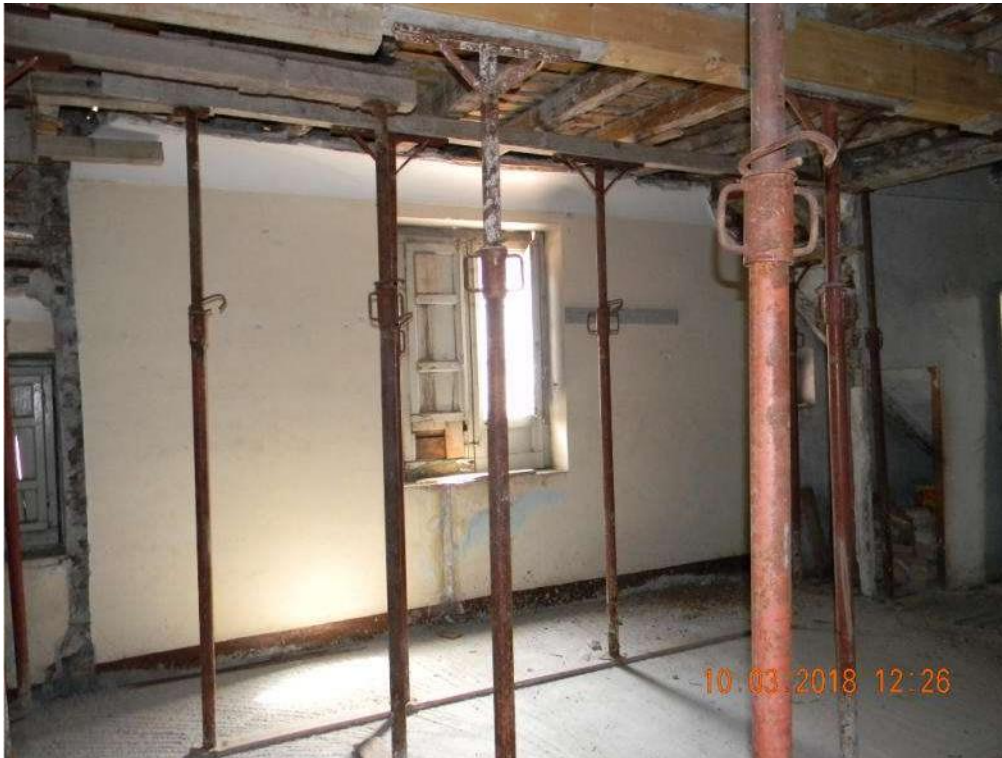
Foto 09 - Altro scorcio della parete est del vano n.2.
