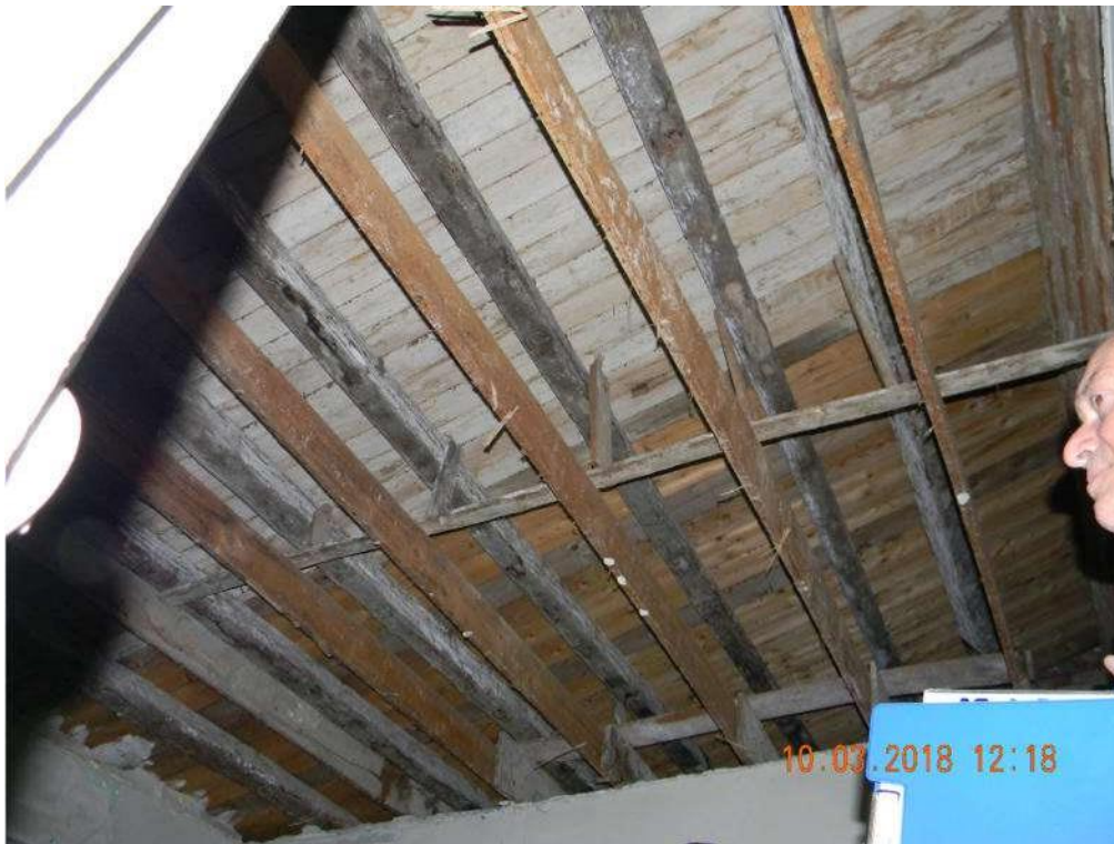
Foto 26 - Soffitto del vano n.7.
