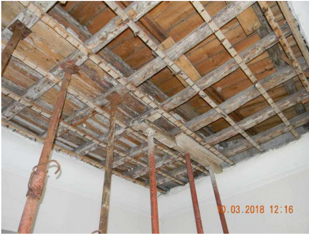
Foto 16 - Soffitto del vano n.3.
