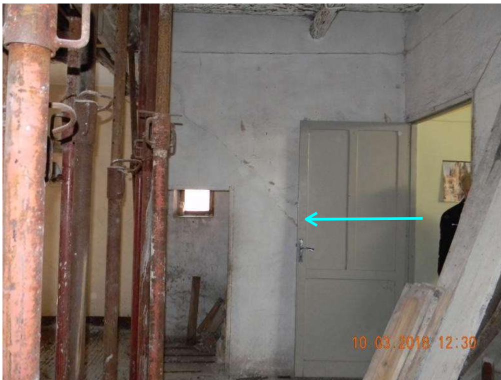
Foto 05 - Ingresso al vano n.2.
