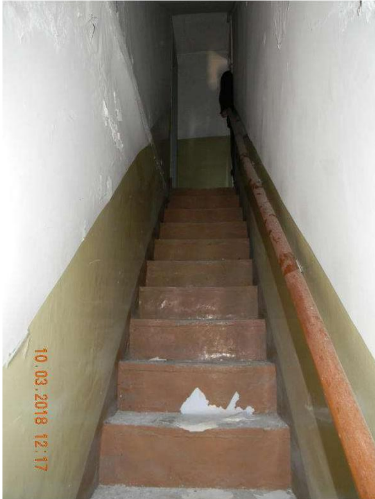
Foto 22 - Scala di accesso al 2° piano.
