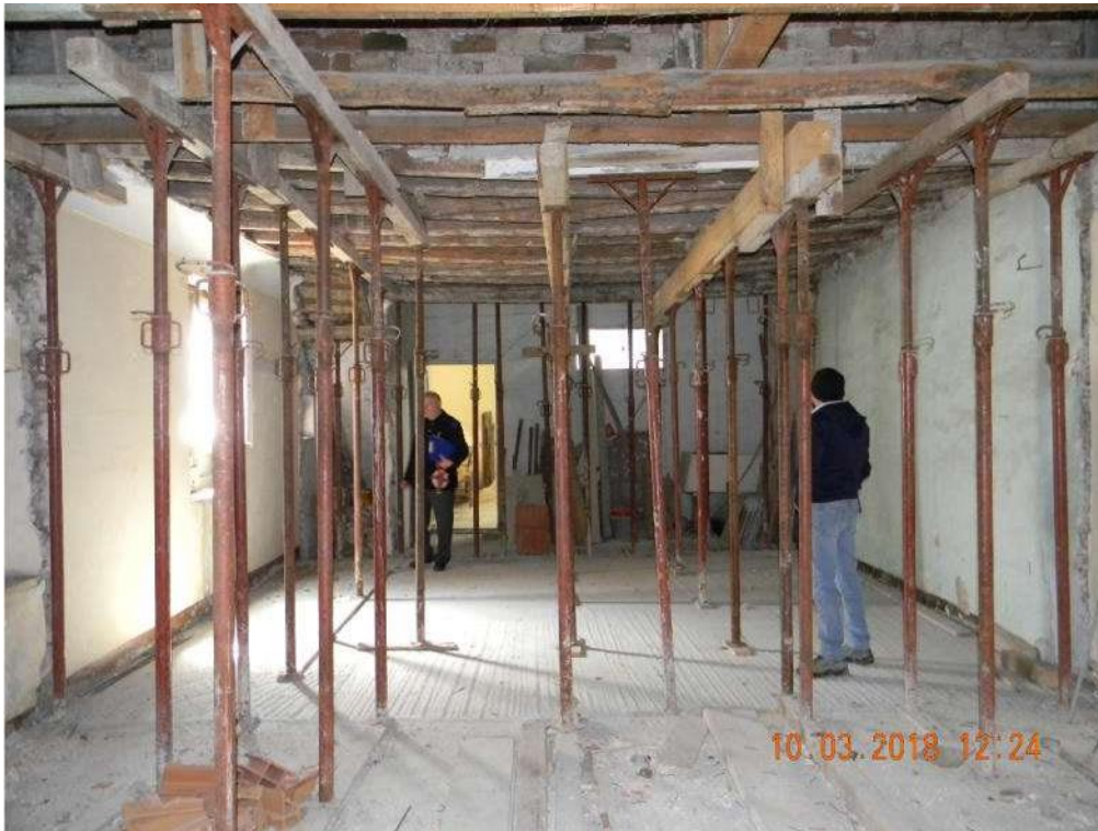
Foto 07 - Vista d'insieme del vano n.2 (foto scattata dando le spalle al C.so Umberto)
