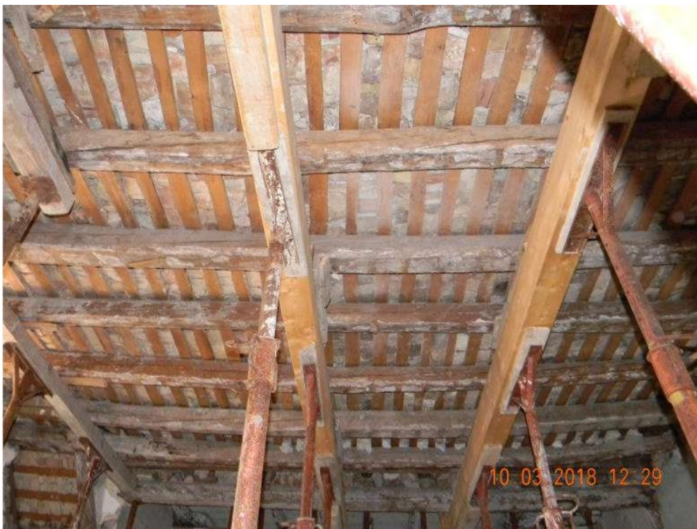
Foto 12 - Soffitto ligneo soprastante parte del vano
