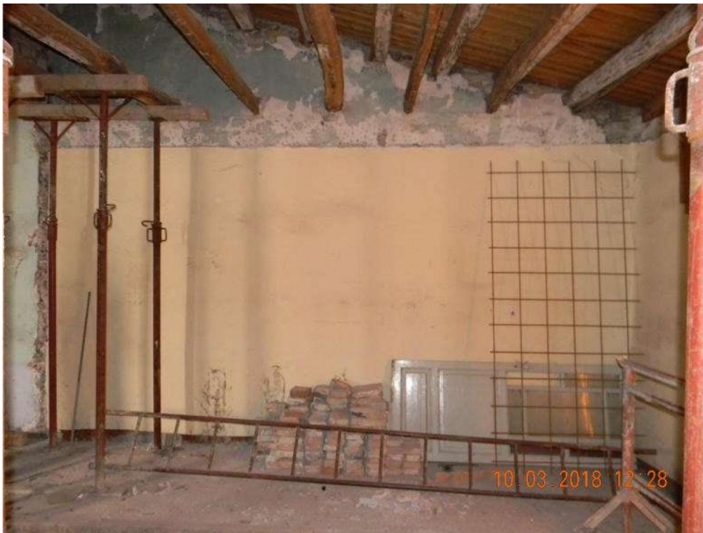
Foto 11 - Altro scorcio della parete ovest del vano n.2.
