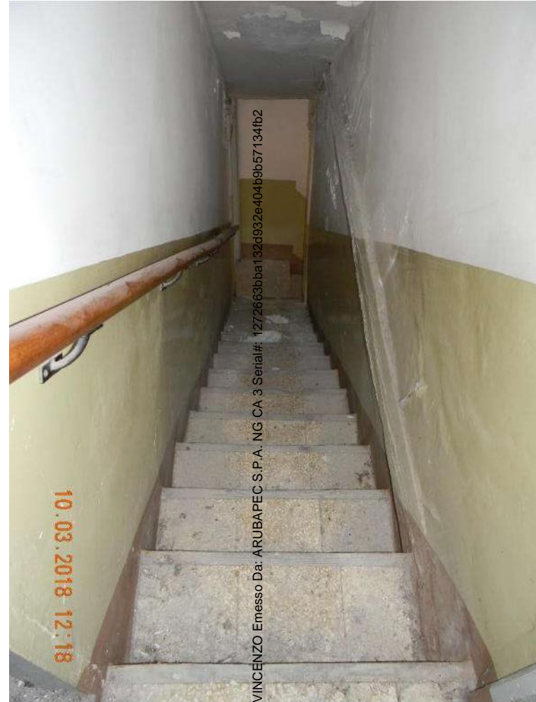
Foto 23 - Altra vista della scala di accesso al 2° piano.
