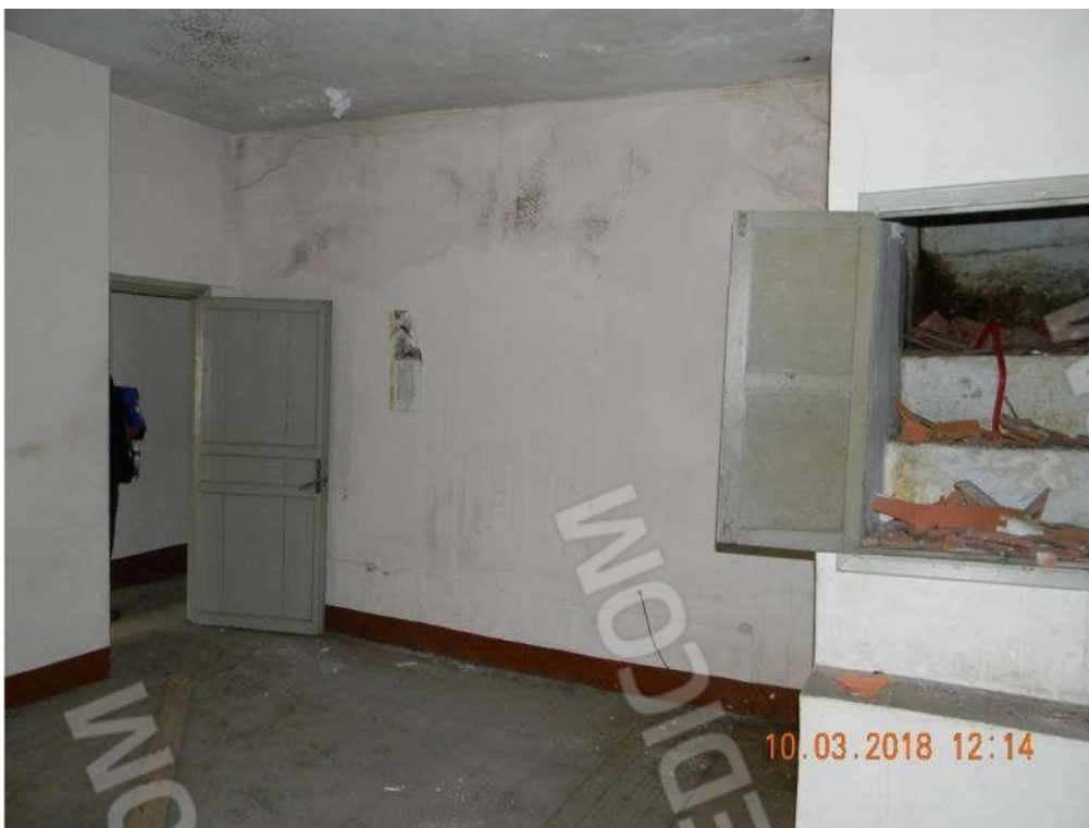
Foto 21 - Altro scorcio del vano n.5.
