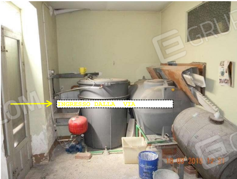
Foto 04 - Altro scorcio del vano n.1.
