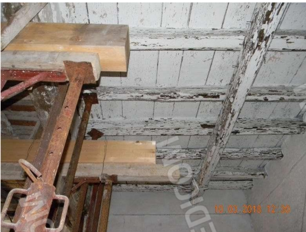
Foto 06 - Soffitto ligneo della zona di cui sopra.
