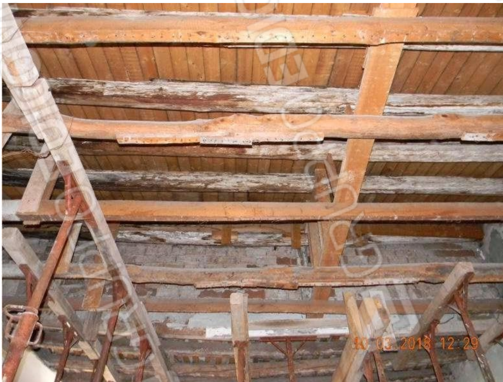
Foto 13 - Falda a struttura lignea soprastante la porzione del vano n.2 prospiciente C.so Umberto
