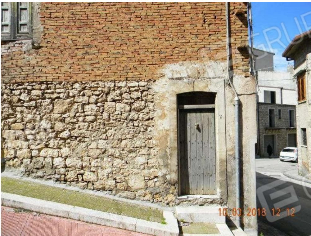
Foto 31 - Portone di ingresso al civ. n.2 della Via Berta. Essendo stata demolita la scala di accesso al piano soprastante a partire da tale ingresso, ad oggi tale apertura conduce soltanto ad un piccolo vano, pure incluso nella vendita, segnato in rosso nella planimetria catastale che segue, relativa al sub.14 della particella 1464 non oggetto, invece, della
