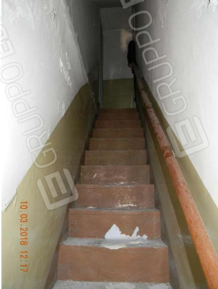
Foto 22 - Scala di accesso al 2° piano.
