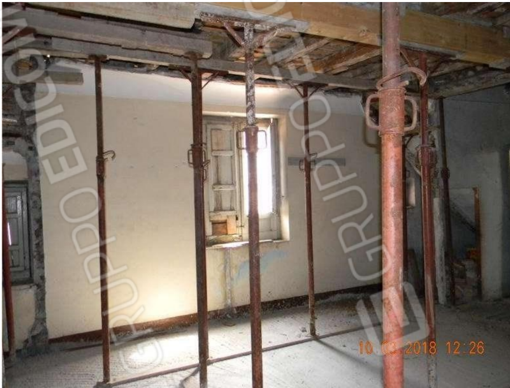
Foto 09 - Altro scorcio della parete est del vano n.2.
