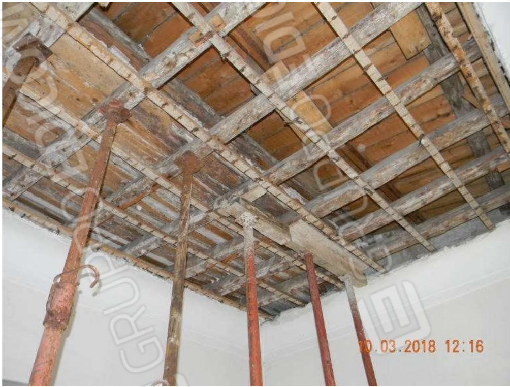
Foto 16 - Soffitto del vano n.3.
