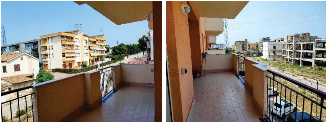
Figure 8 – Panoramica lato Ovest
