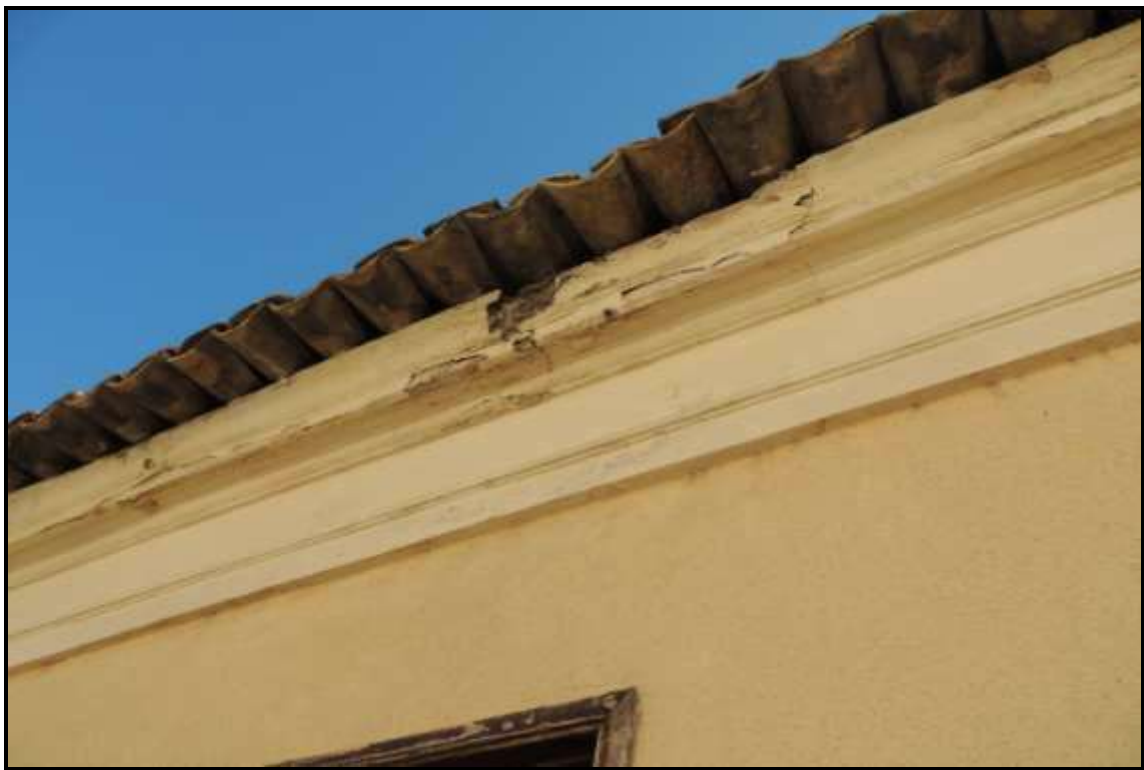
Foto 4: Degrado cornice su prospetto principale
