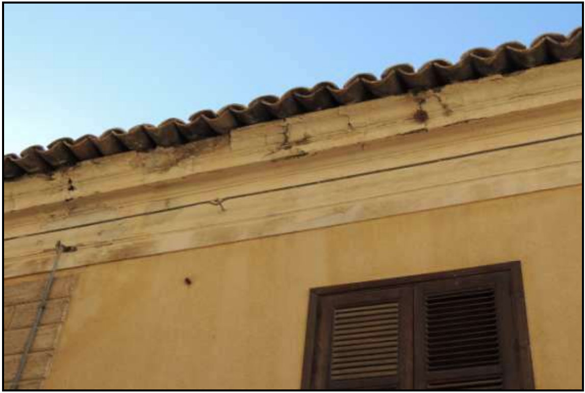
Foto 6: Degrado cornicione su prospetto di Via Novembre
