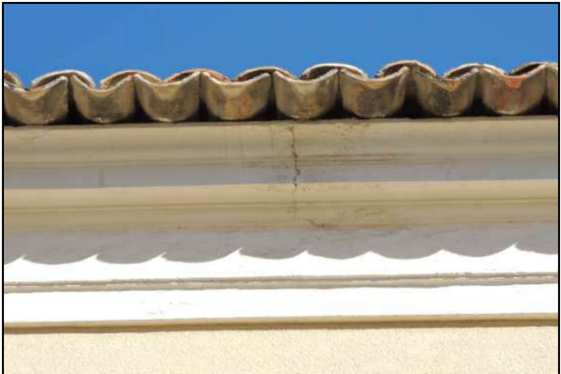
Foto 6: Degrado cornicione su prospetto di Via Novembre
