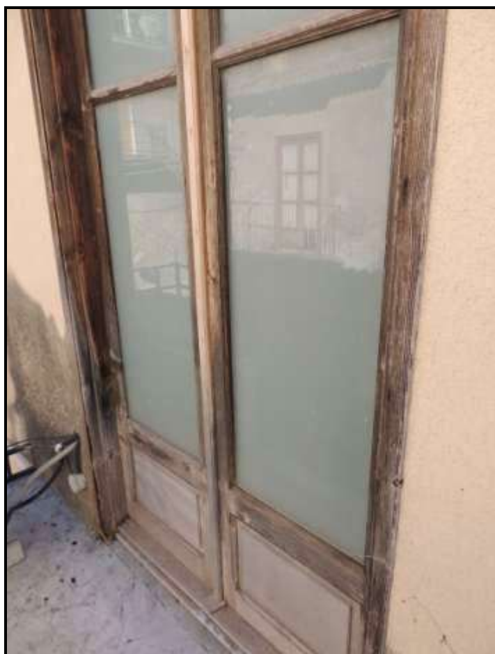
Foto 40: Particolare degrado infissi esterni
