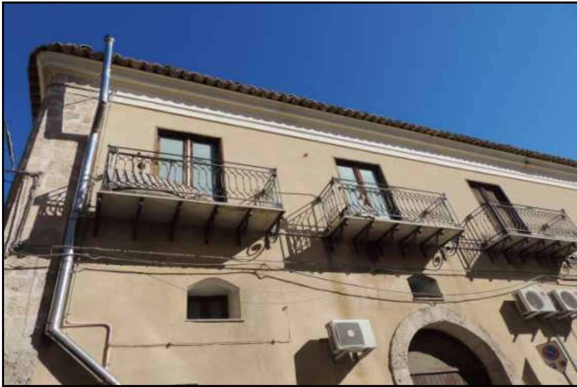
Foto 4: Degrado cornice su prospetto principale
