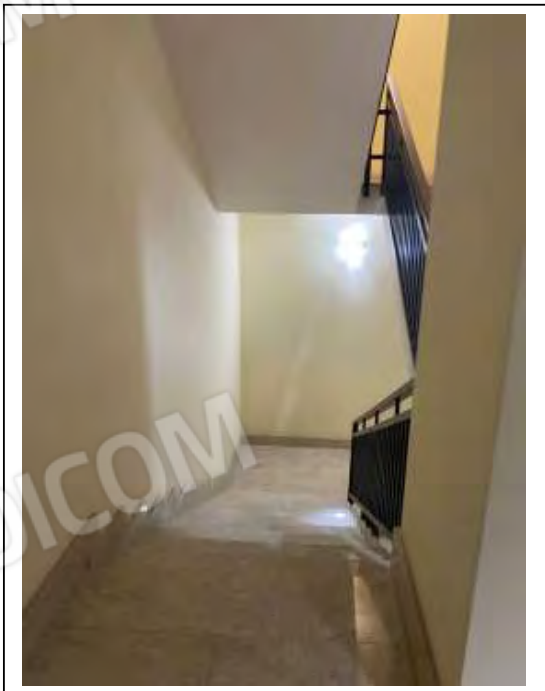
Fotografia n. 8 – Interno – scala condominiale
