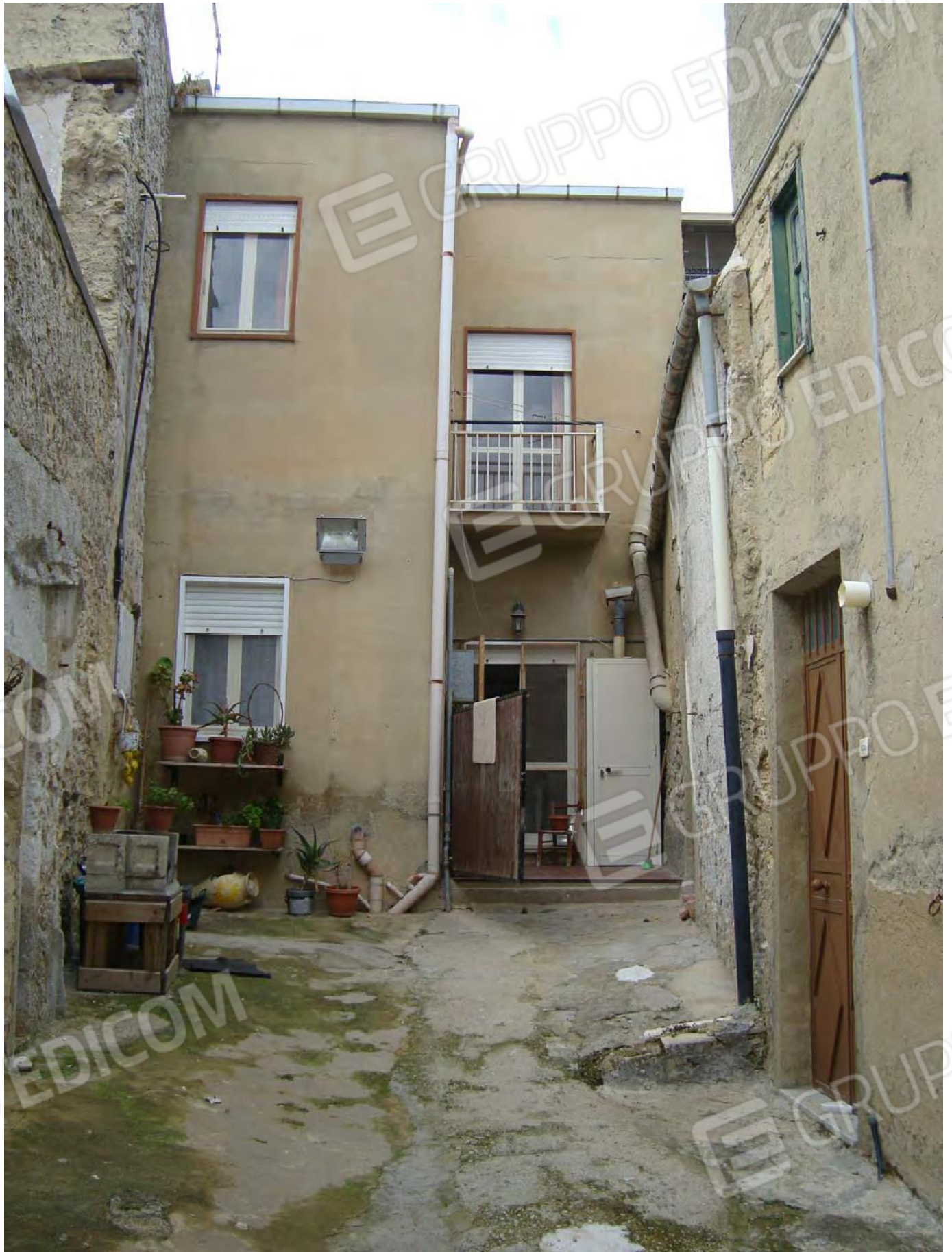
Prospetto su cortile via Varese
