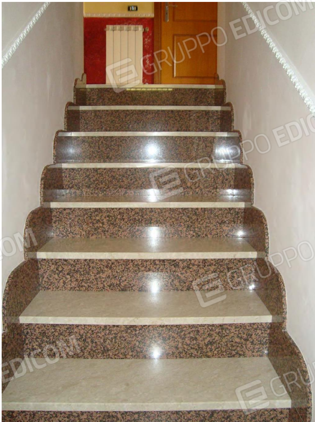
SCALA DI COLLEGAMENTO TRA P.T.-1°
