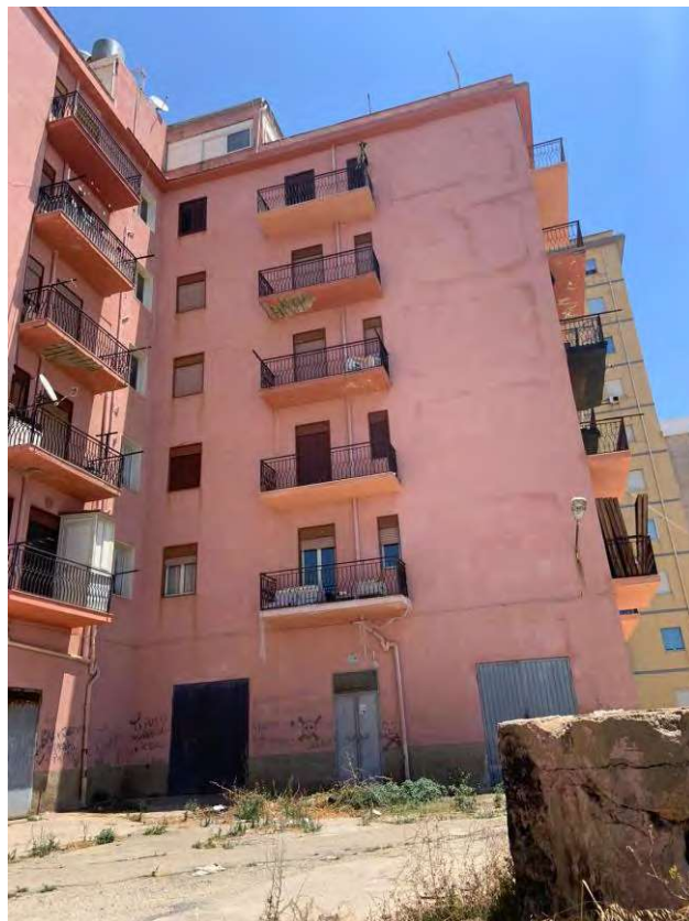
17. Prospetto ovest fabbricato
