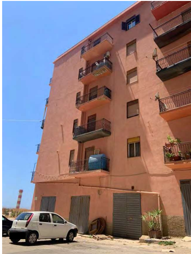
16. Prospetto est fabbricato - lato via Rimini
