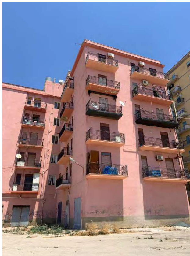
1. Prospetto esterno – lato sud-ovest
