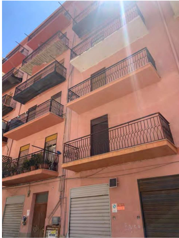
14. Prospetto nord fabbricato - lato via Taranto
