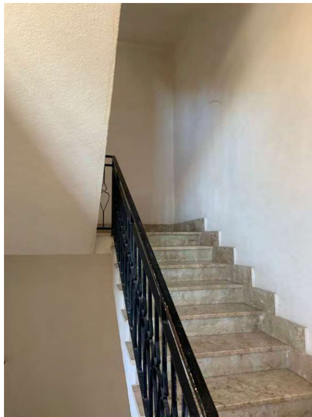
19. Vano scala del fabbricato
