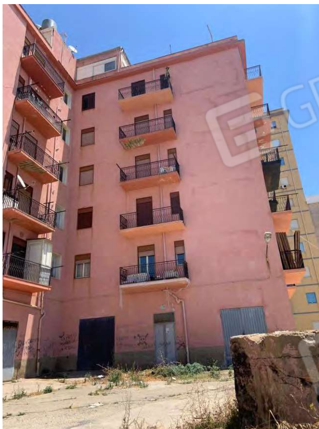
17. Prospetto ovest fabbricato
