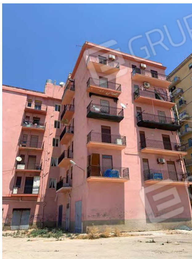
1. Prospetto esterno – lato sud-ovest
