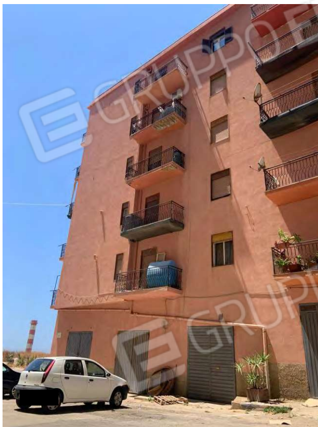
16. Prospetto est fabbricato - lato via Rimini
