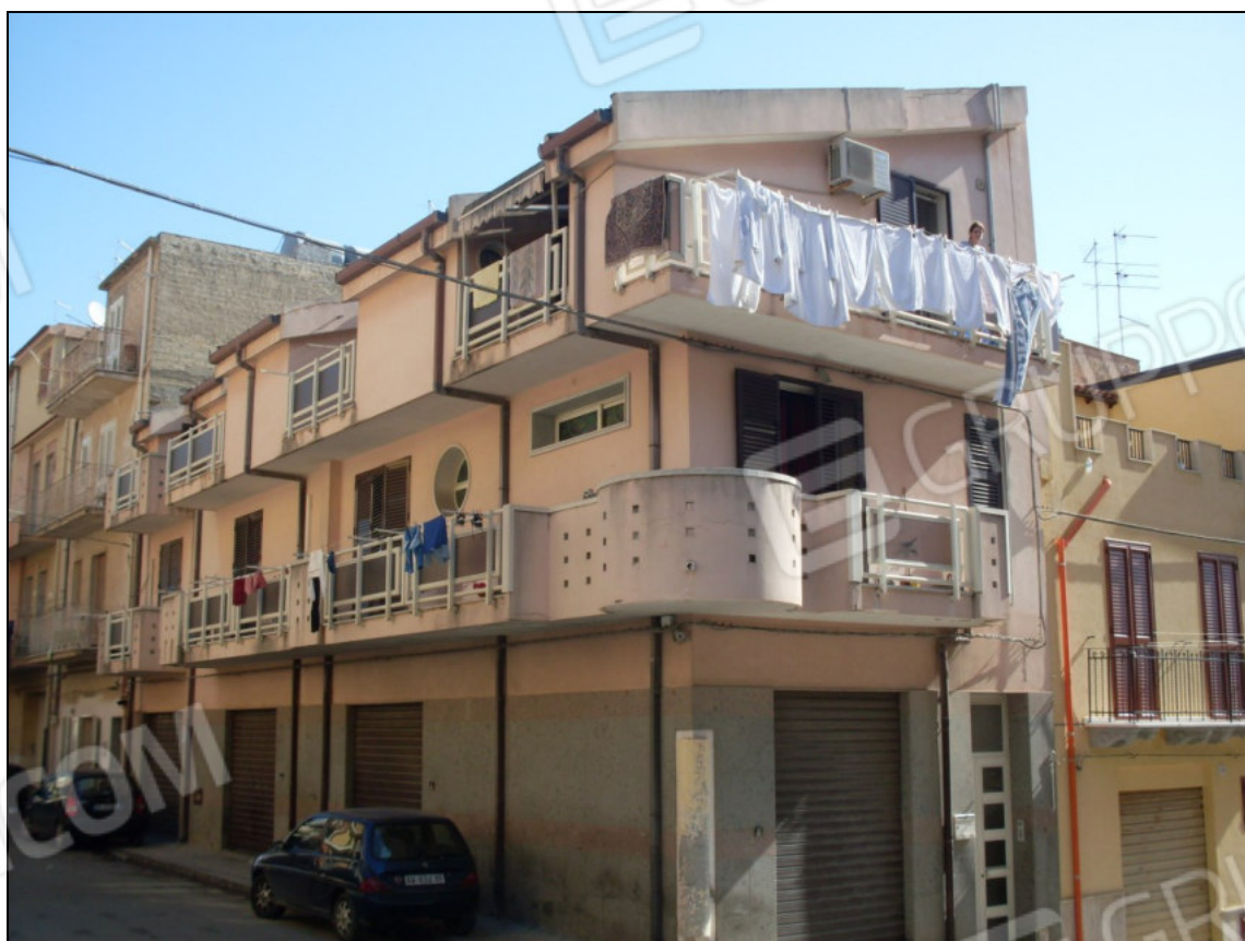
Foto 1 e 2: Vista esterna dell'intero fabbricato
