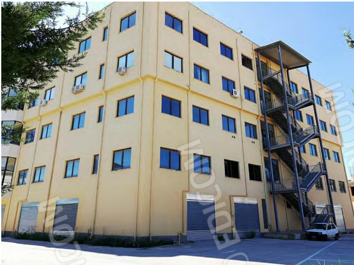
Prospetto posteriore nord-ovest intero fabbricato
