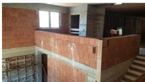
predisposizione per il vano ascensore
