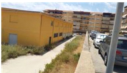
pavimentazione esterna con presenza di pavimenti drenanti (coperti dalla vegetazione)
