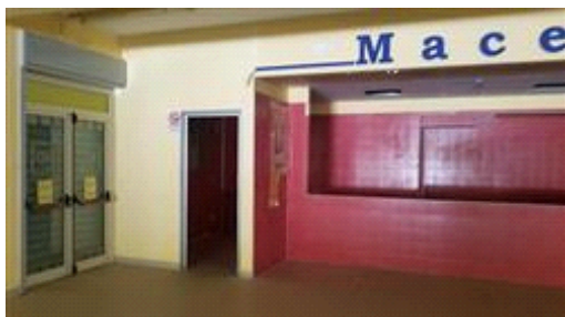
porte di ingresso antipanico e rifinitura pareti
