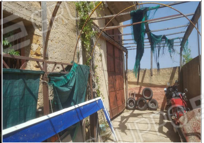
Foto n.10: Ingresso magazzino a piano terra p.1302/2
