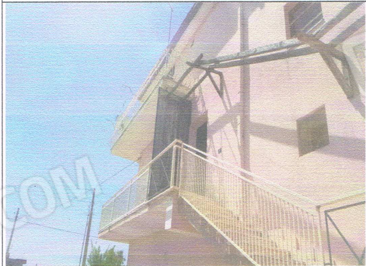
Foto n.3: Accesso appartamento 2° piano
