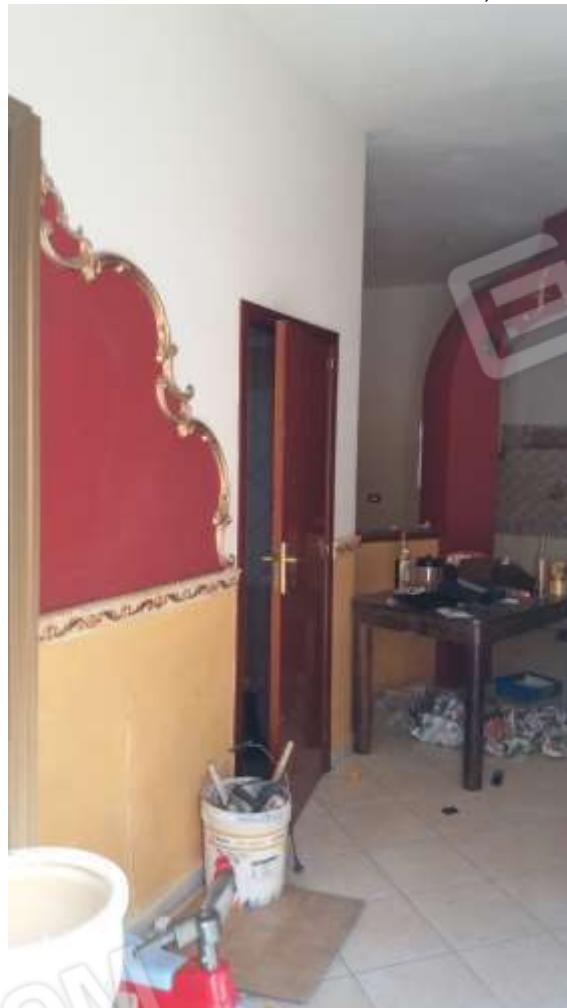
FOTO 8 - Veduta del wc a piano terra.
