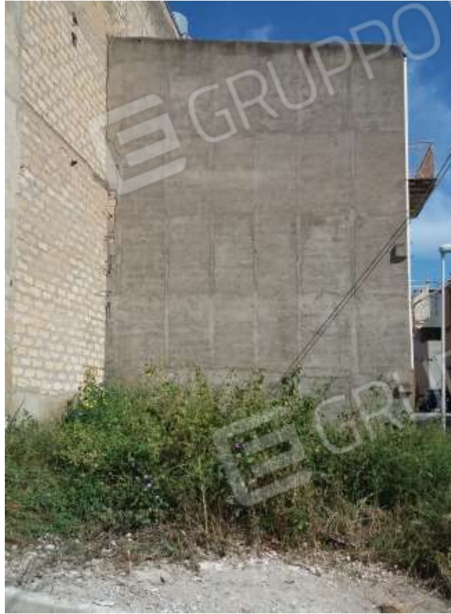
FOTO 3 - Veduta del prospetto laterale;
