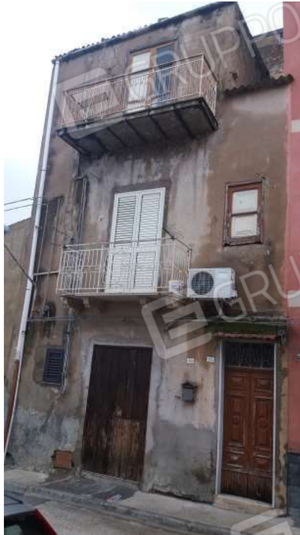
FOTO 1 - Veduta dell'unità immobiliare, sito in Via Cangiamila 53
