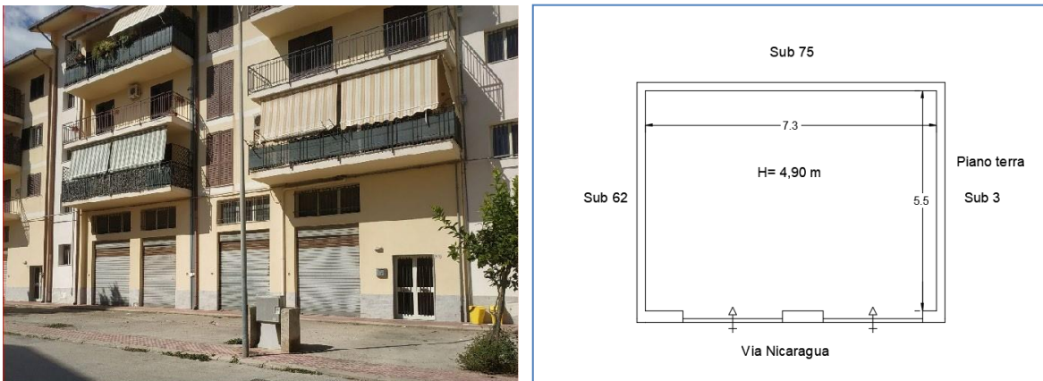
Figure 4 – Vista esterna del magazzino e rilievo metrico dello stato dei luoghi
