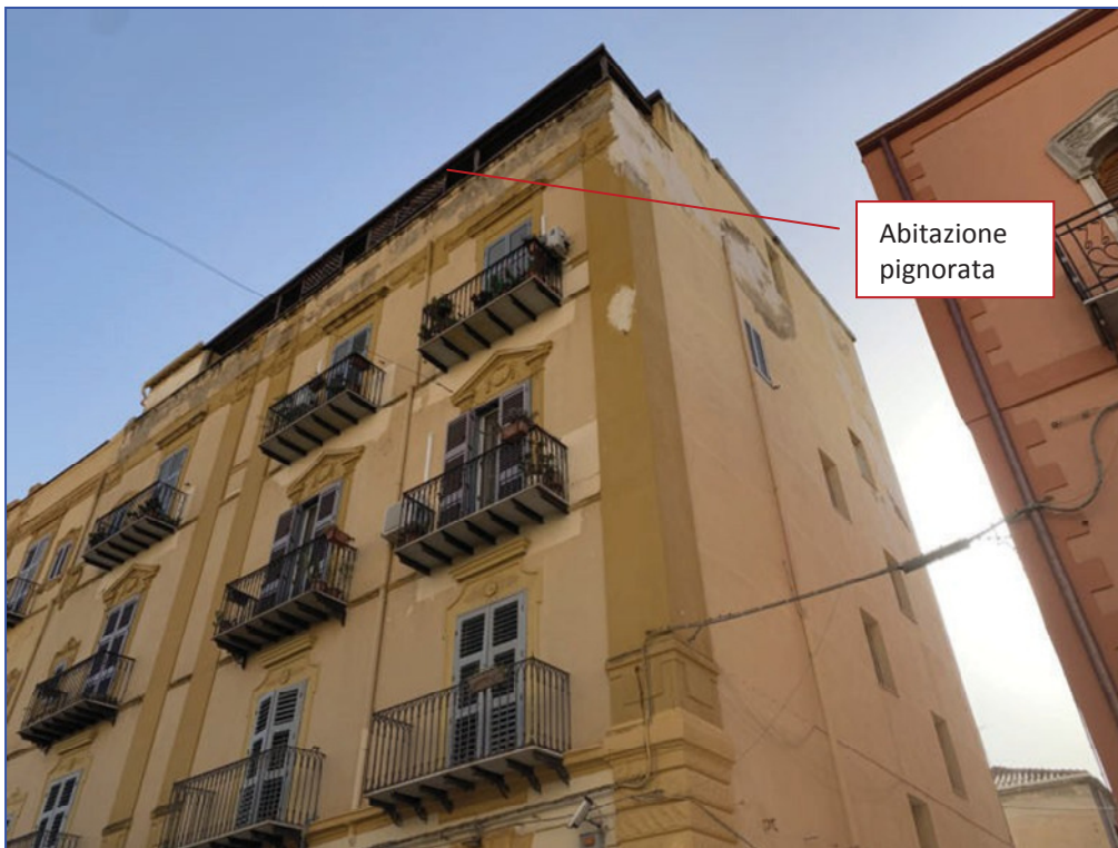
Immagine n.2 – Vista Fabbricato.
