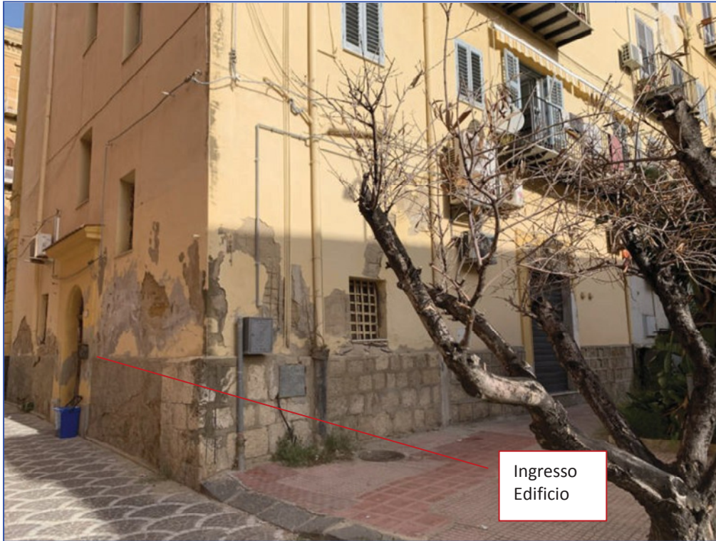
Immagine n.1 – Vista fabbricato.
