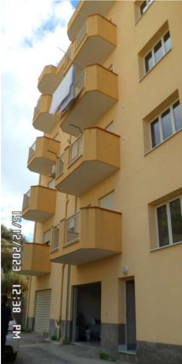
Foto 5 – Veduta dell'ingresso dell' autorimessa
