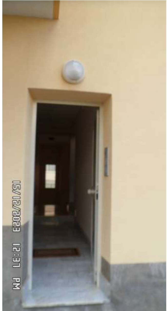
Foto 6 – Veduta del portone della scala del palazzo sul retro nello spazio condominiale
