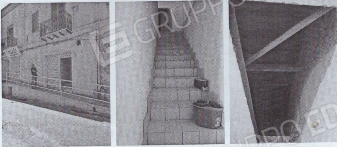
Figura 7 – A sinistra vano di accesso al piano primo, al centro il vano scala ed a sinistra botola per accesso al sottotetto
