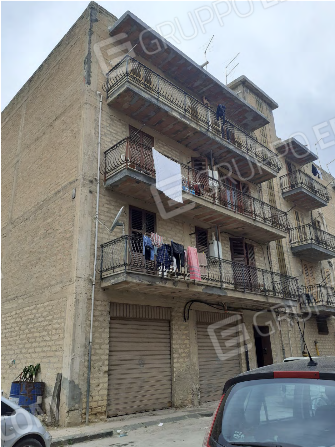
FOTO 1 : Veduta del prospetto del fabbricato su Via Don Luigi Sturzo, con individuazione appartamento pignorato a piano primo
