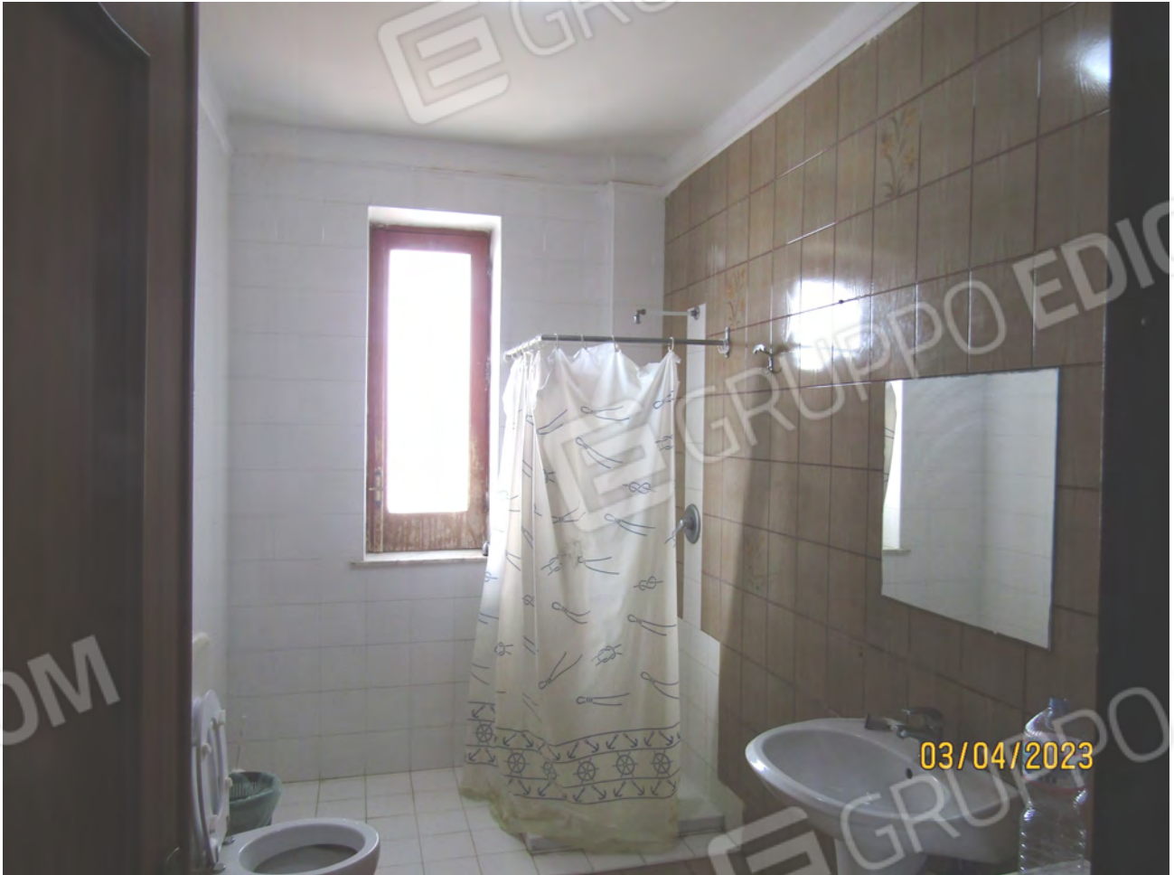
FOTO 11: Veduta del bagno
