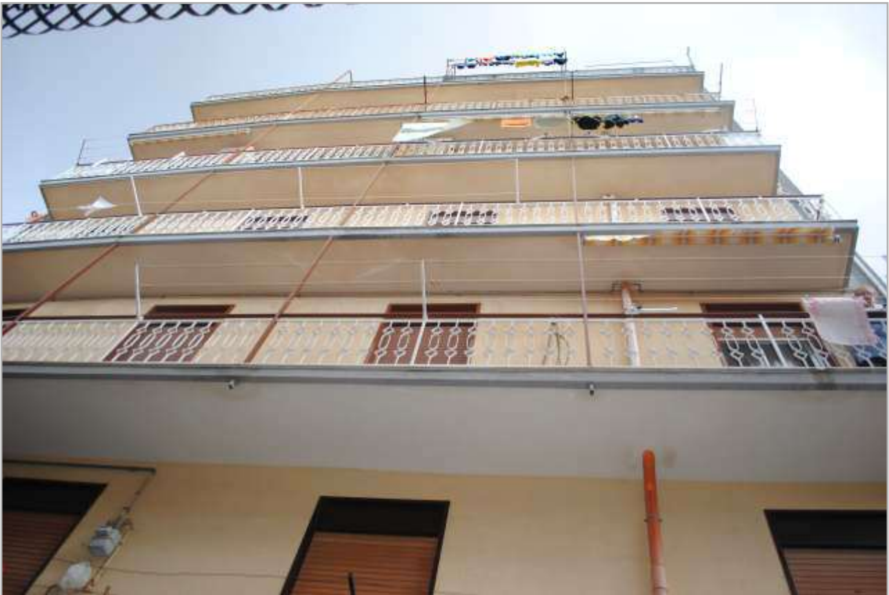
AFFACCI ED ACCESSO SU VIA CASTRONOVO
