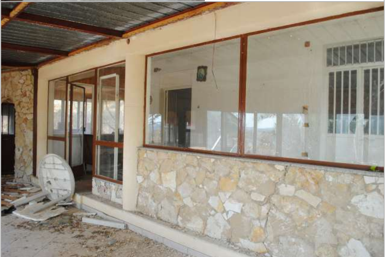
VERANDA E INGRESSO FABBRICATO
