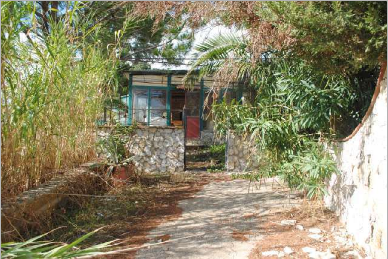
ACCESSO AL FABBRICATO - LATO SUD/EST
