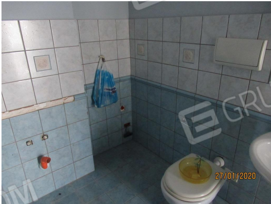
Lotto 01 – fotografie interne (piano terra)
