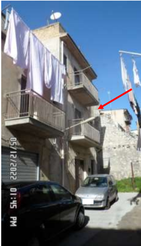
FOTO 1 - VEDUTA DAL C.LE CARAMANNO DELL'IMMOBILE
