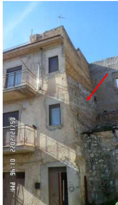
FOTO 4 - VEDUTA LATO NORD
