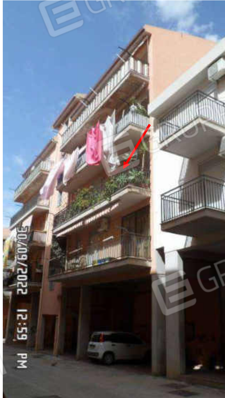
FOTO 4 - VEDUTA DELL'APPARTAMENTO DALLA VIA MARINUZZI
