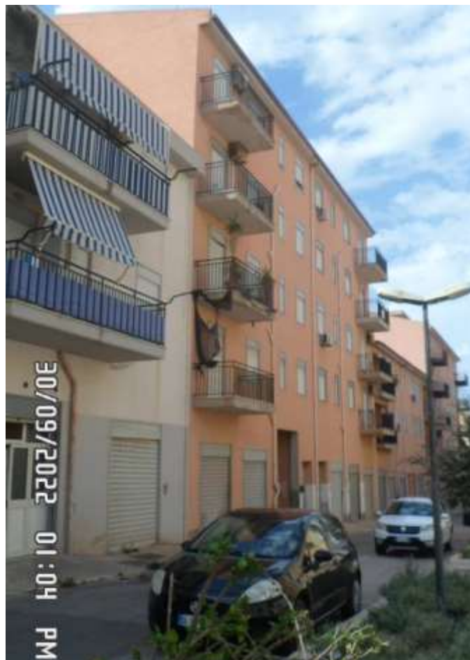
Foto 1 – Veduta del prospetto nord sulla via Novelli.
