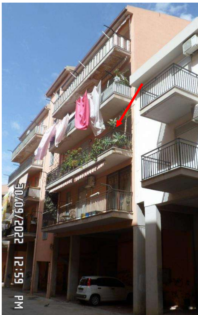
Foto 4 – Veduta dell'appartamento dalla via Marinuzzi.
