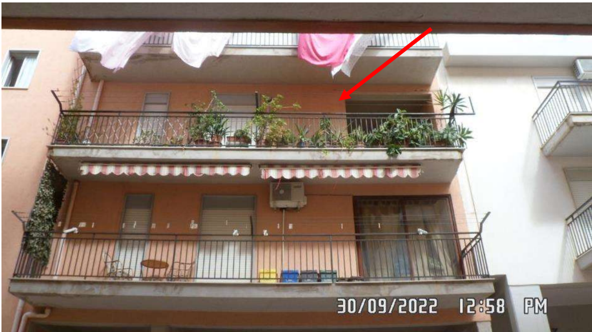
Foto 3 – Veduta dell’appartamento dalla via Marinuzzi.
