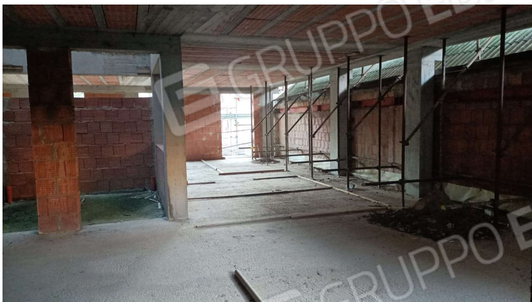
VISTA INTERNA LOTTO N. 3
