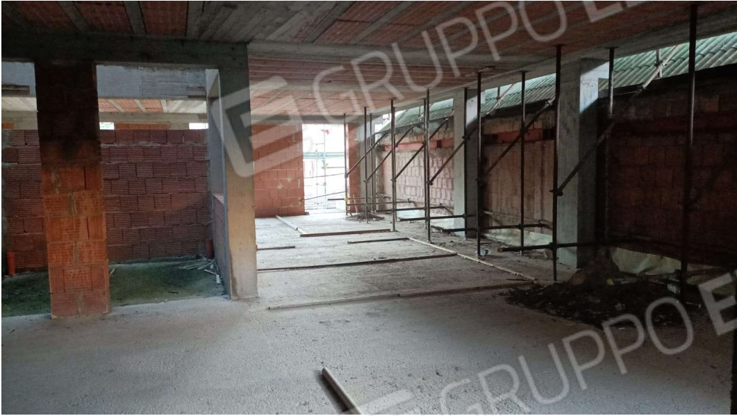
VISTA INTERNA LOTTO N. 4
