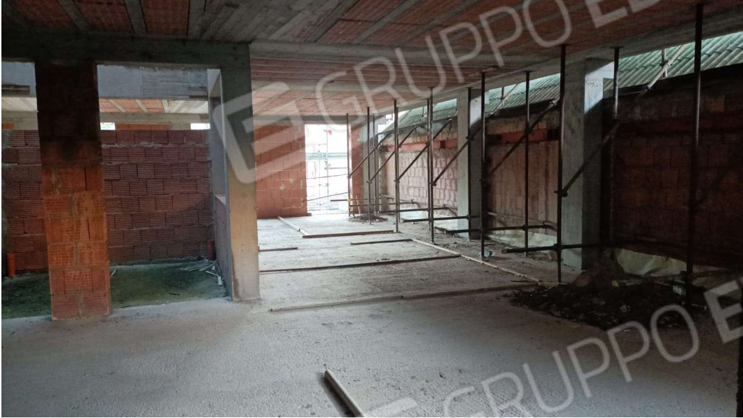
VISTA INTERNA LOTTO N. 8
