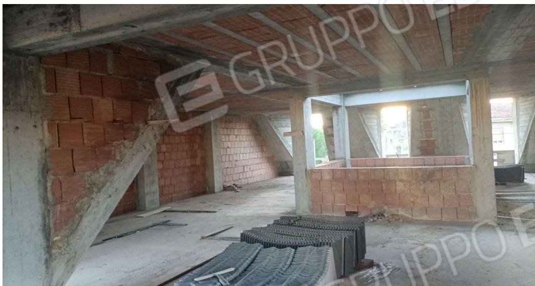
VISTA INTERNA SOTTOTETTO LOTTO 10
