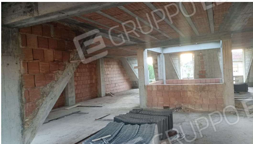
VISTA INTERNA SOTTOTETTO LOTTO 11
