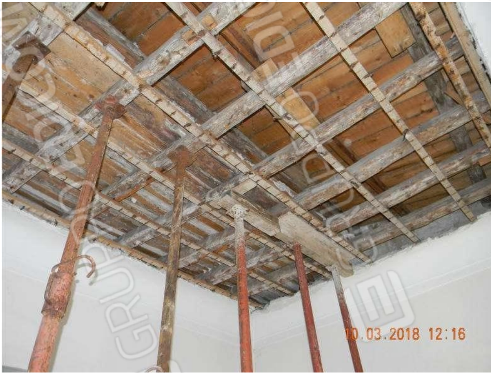
Foto 16 - Soffitto del vano n.3.
