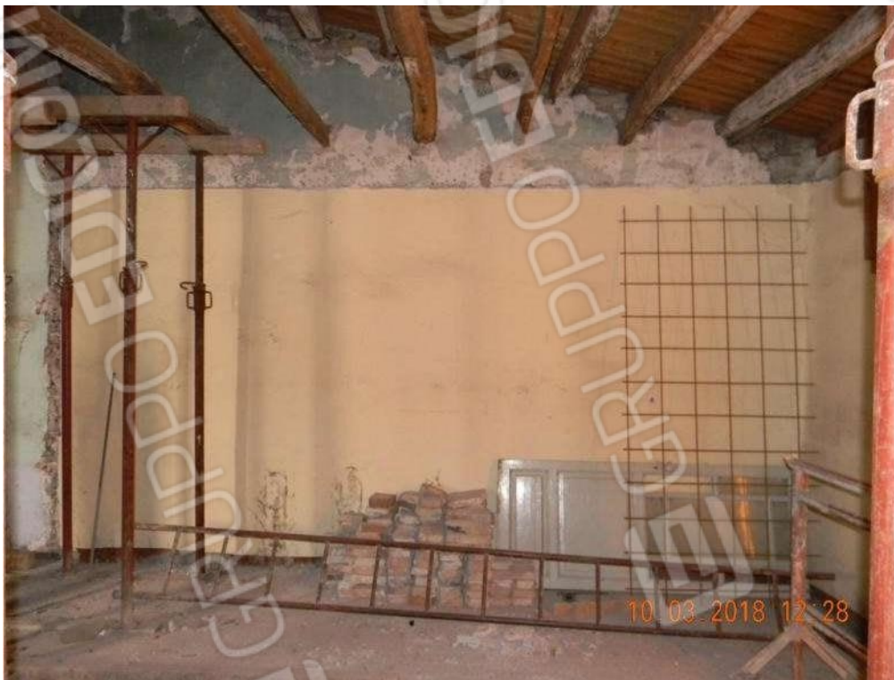
Foto 11 - Altro scorcio della parete ovest del vano n.2.
