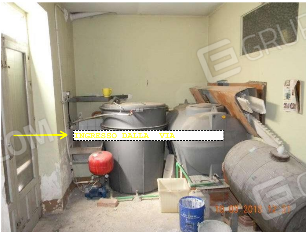
Foto 04 - Altro scorcio del vano n.1.
