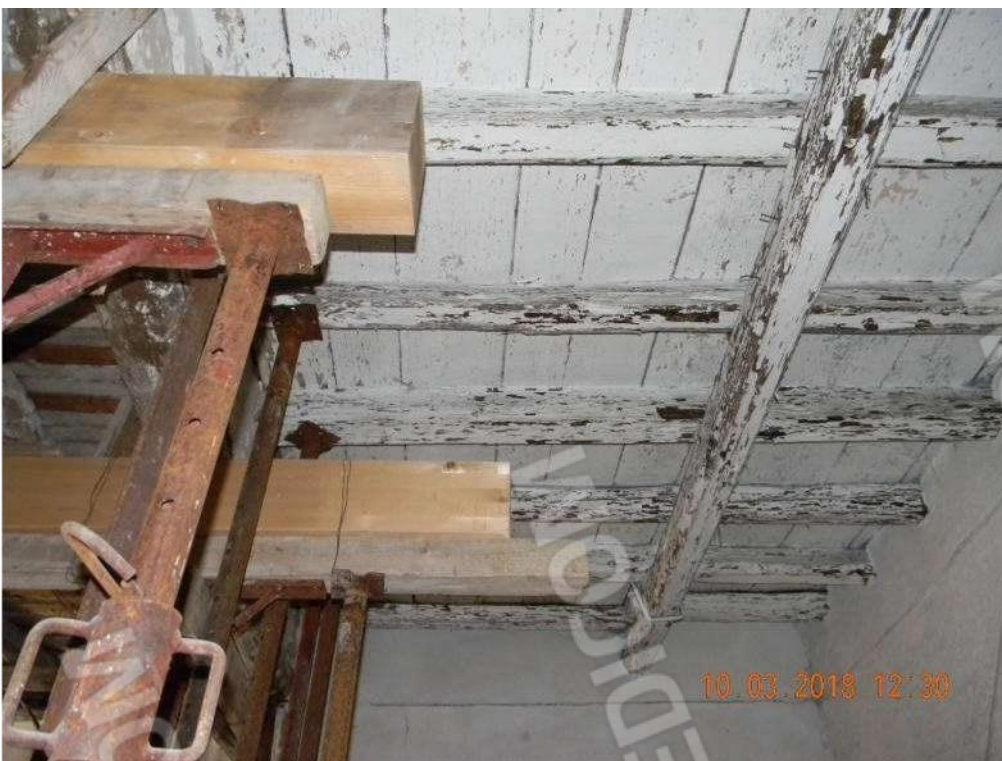
Foto 06 - Soffitto ligneo della zona di cui sopra.
