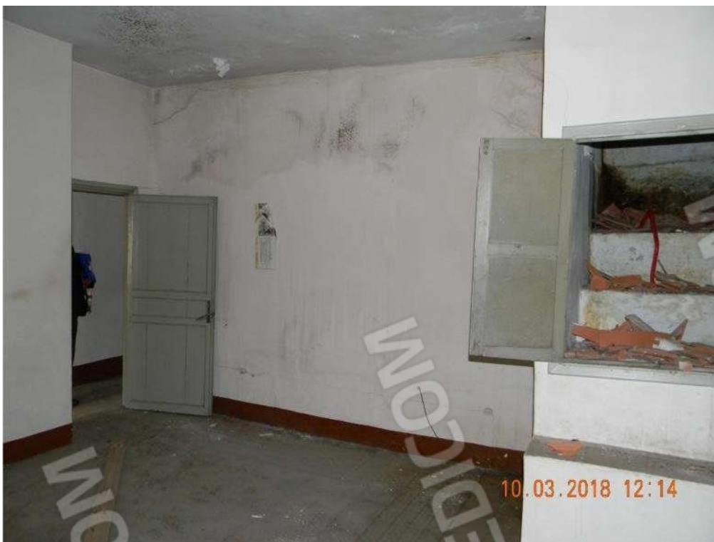
Foto 21 - Altro scorcio del vano n.5.
