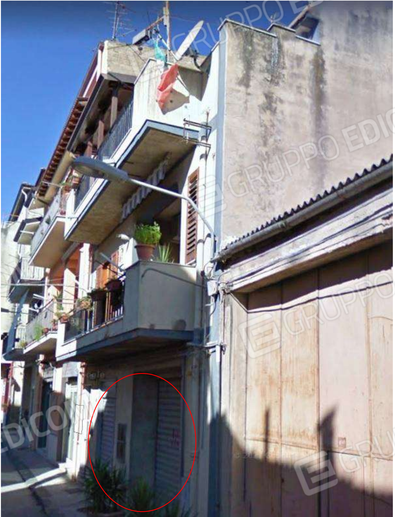
Foto 24 – Ingresso stabile da via Soldato Barbera 33 35
