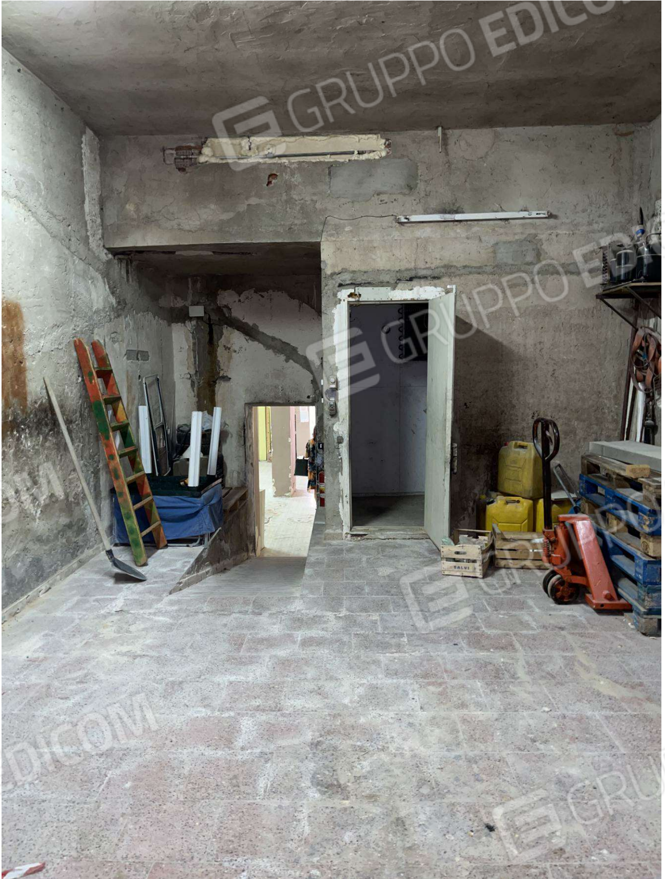
Foto 3 – Porta ripostiglio e di collegamento con il sub 12
