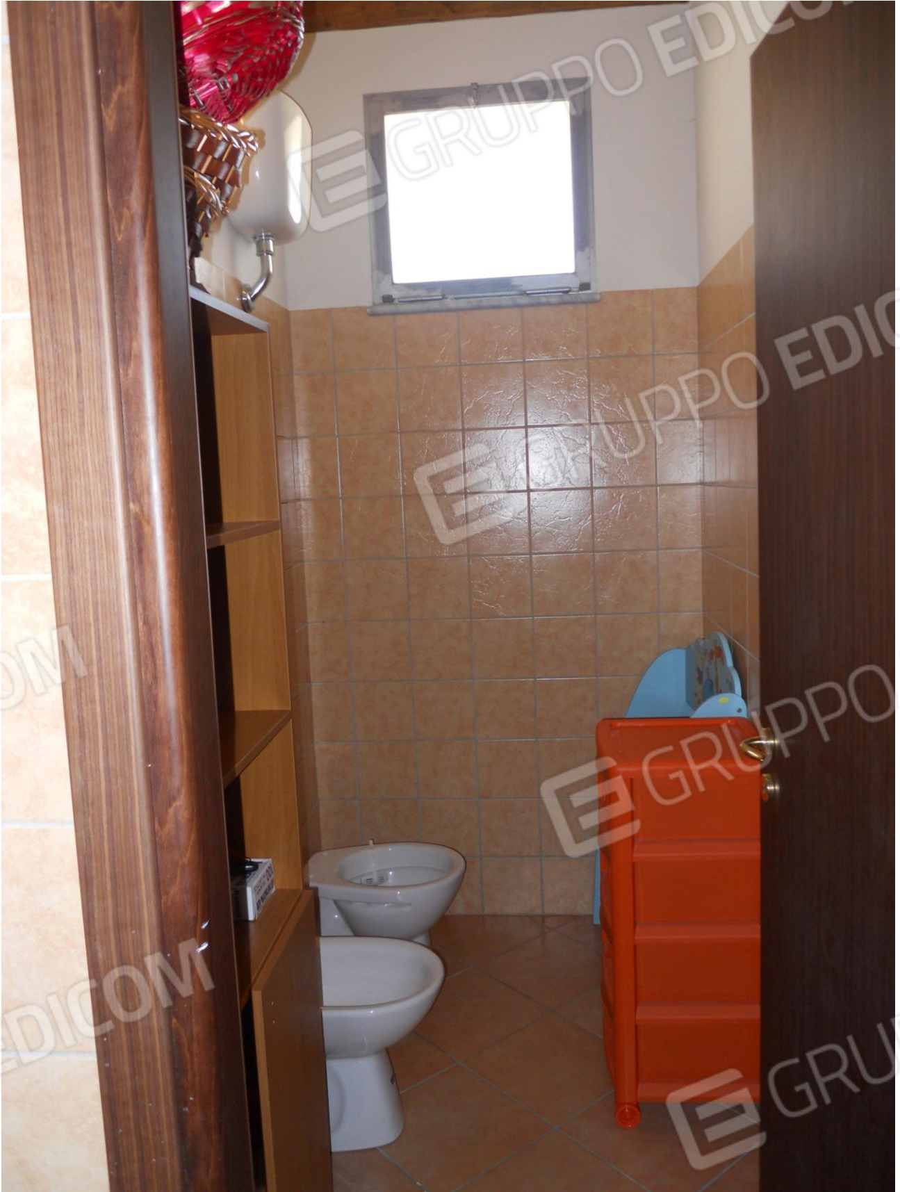
Foto 11 – Locali WC (Abusi edilizi da demolire e ripristinare allo stato originario)
