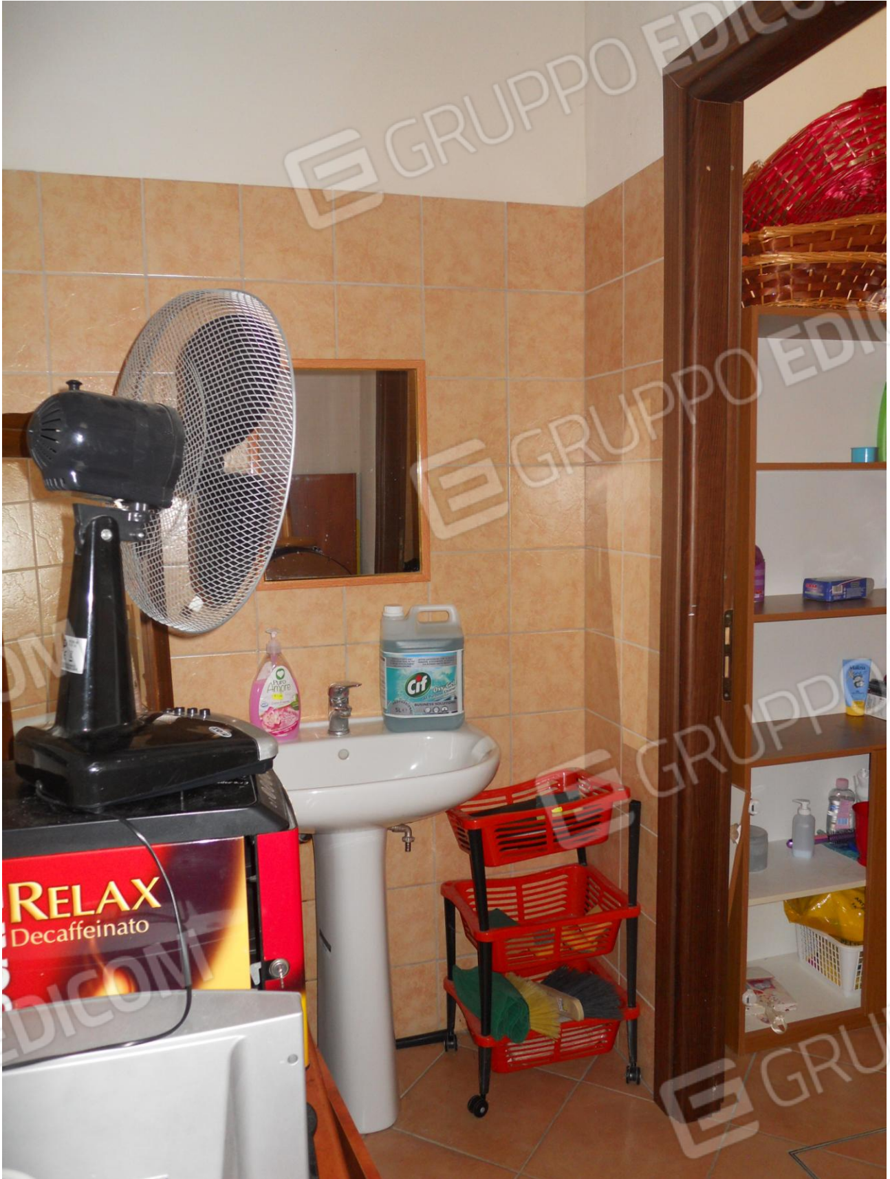
Foto 12 – Locali WC (Abusi edilizi da demolire e ripristinare allo stato originario)
