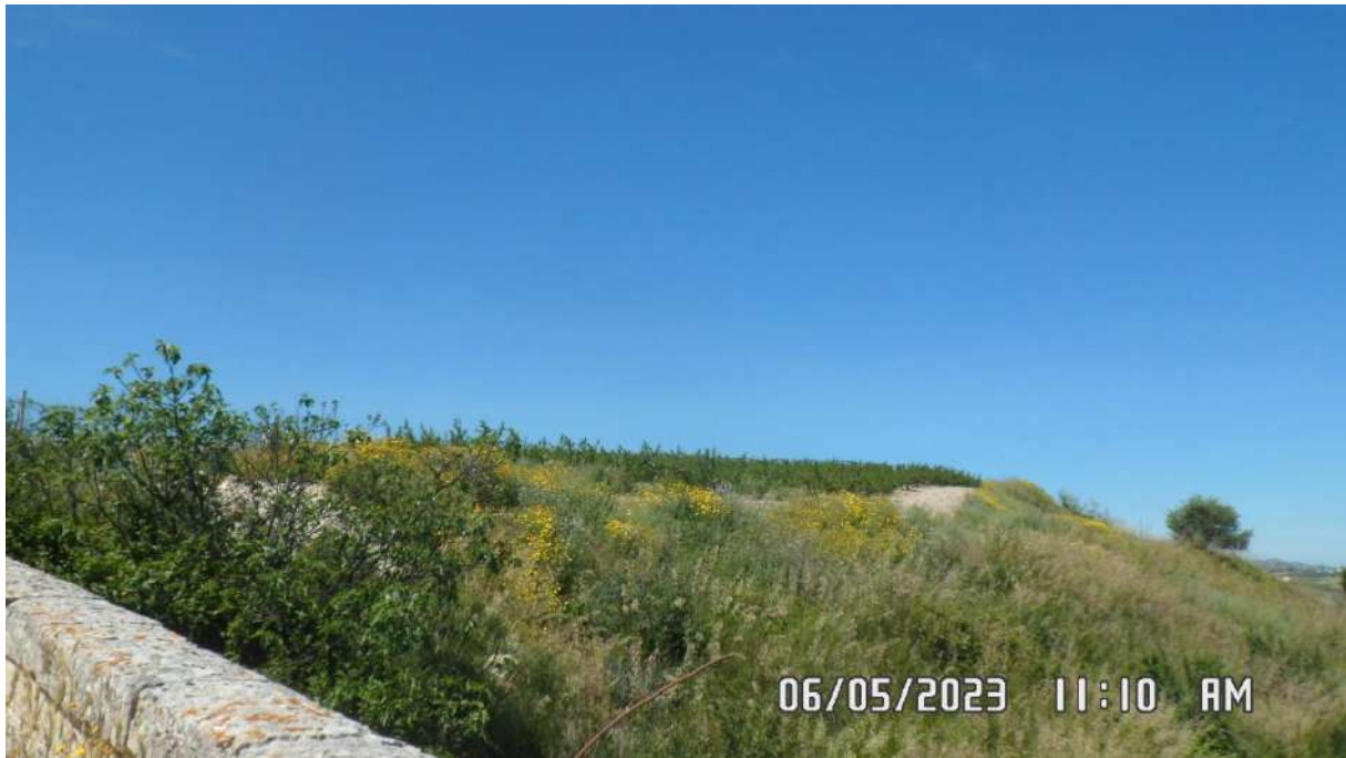
FOTO 1 – VEDUTA DA NORD – EST
