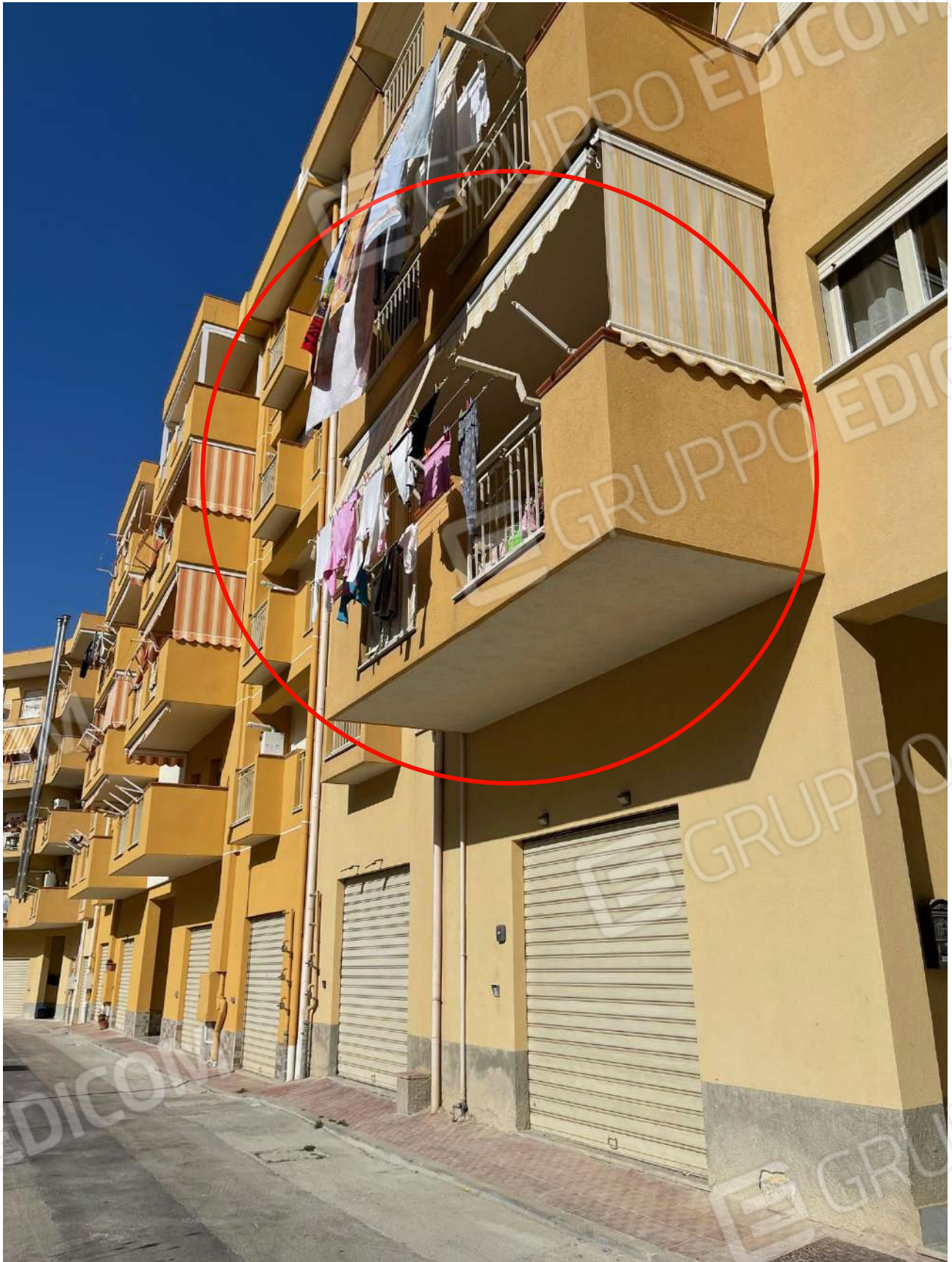
Foto 12 – Balcone su prospetto principale
