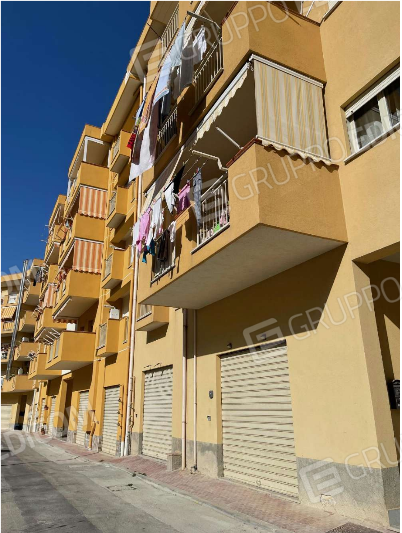
Foto 1 – Ingresso stabile su via Antonino Cassarà
