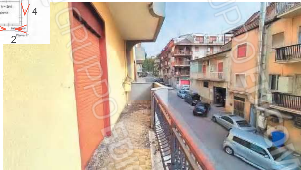
Balcone a Sud lato Via Amendola
