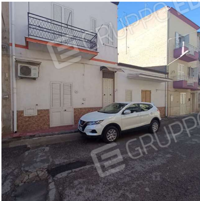
VISTA ESTERNA (VIA TRASIMENO)
