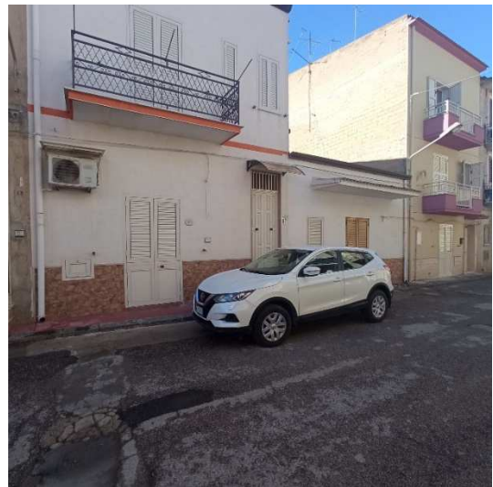
Accesso da via Trasimeno
