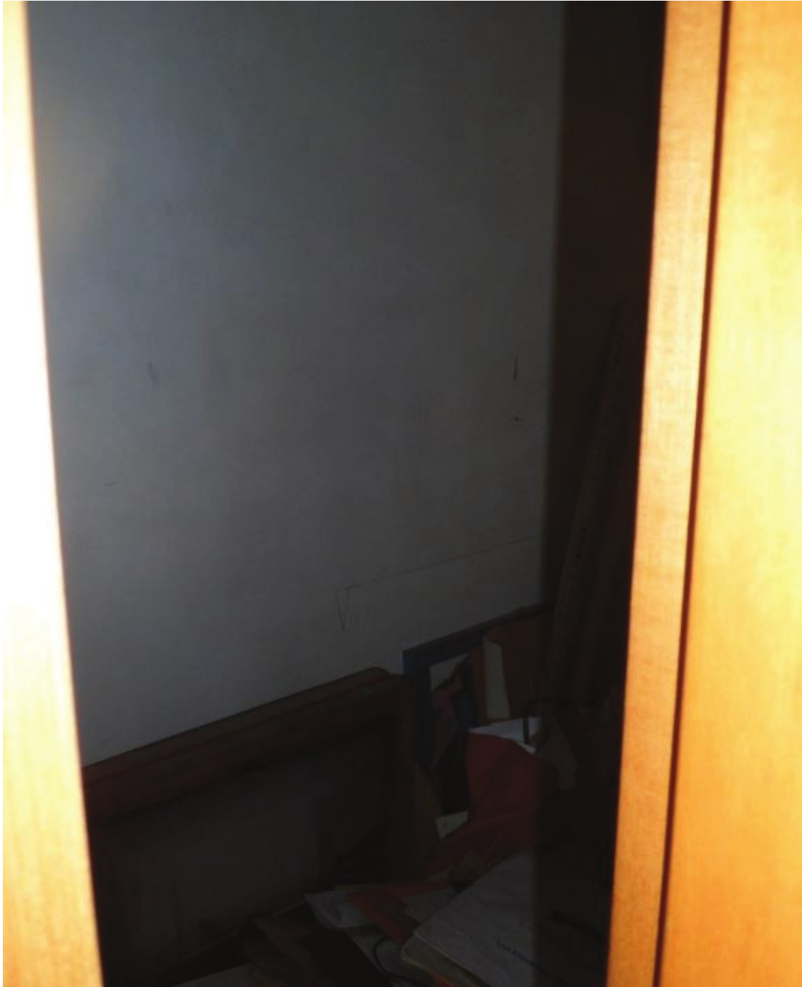
9.6. FOTO - Veduta del ripostiglio.
