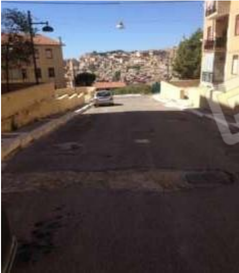
Foto 1 via P. Geremi ingresso palazzina B
