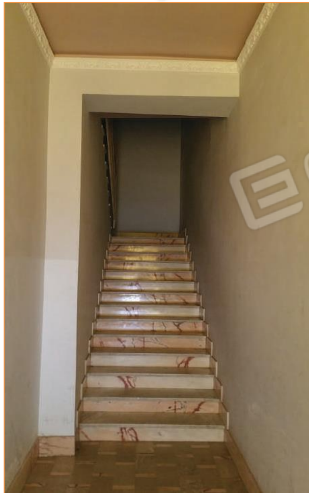
Foto 2 - Vista Sul vano scala
