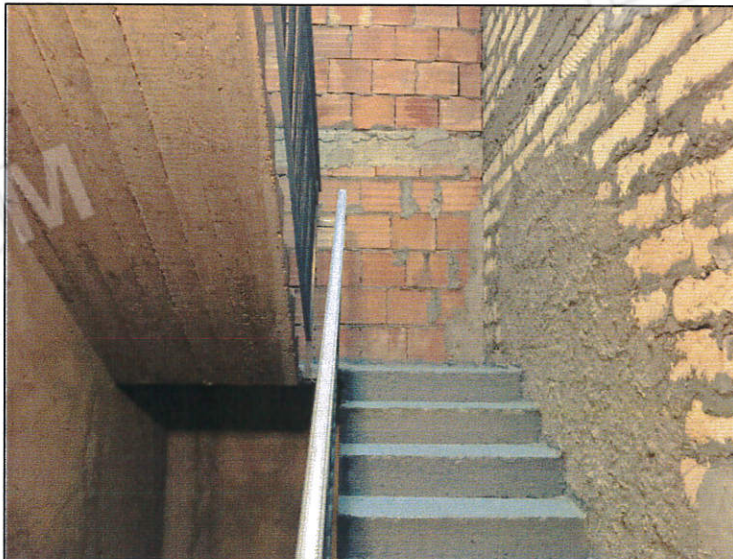
Vista del corpo scala
