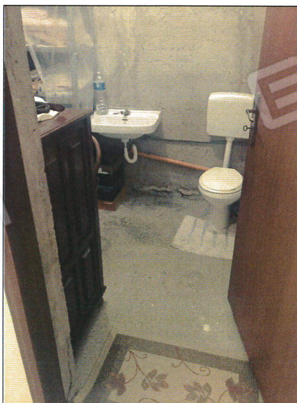
Vista interna del servizio igienico
