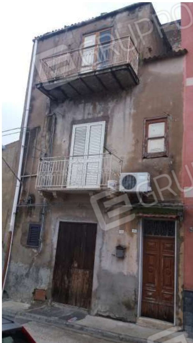
FOTO 1 - Veduta dell'unità immobiliare, sito in Via Cangiamila 53
