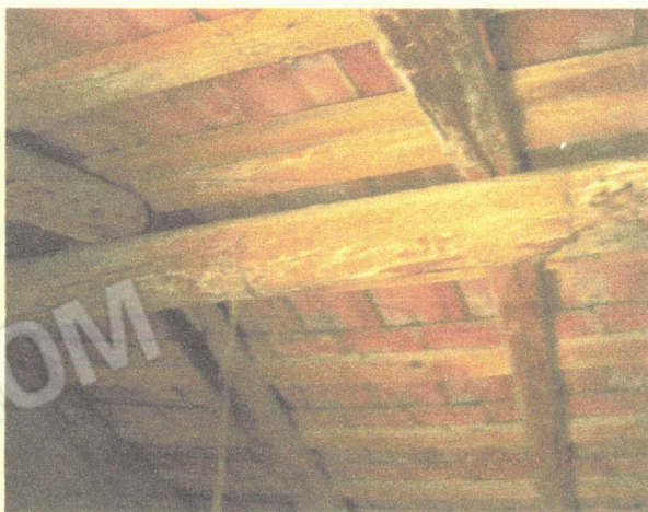
Foto 15 particolare copertura a falde del sottotetto
