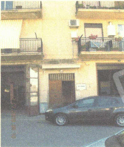
Foto 1 Prospetto ovest su Via Sergio Leone
