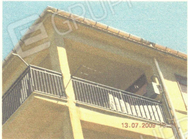
Foto 4 Particolare del terrazzo
