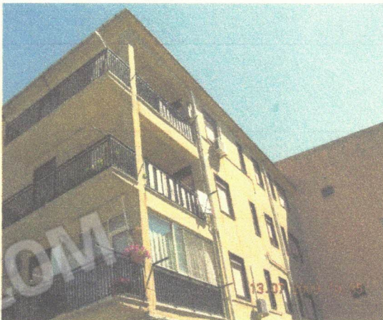
Foto 3 Particolare angolo sud- ovest
