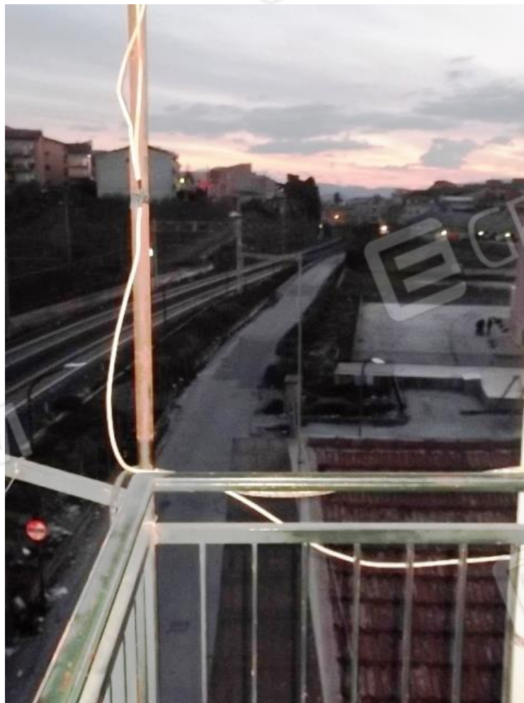
INGRESSO EDIFICIO E VISTA APPARTAMENTO VIA CILEA N. 13 CANICATTÌ Giudice Dott.ssa Maria CULTRERA Perito: Arch. Dino Serra
