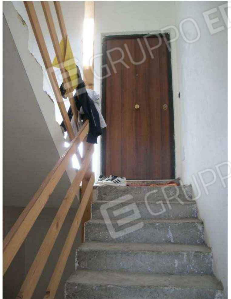
VISTE DEL VANO SCALA
