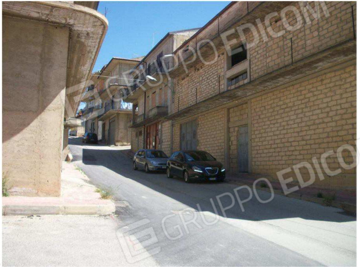
VISTA SULLA VIA TIRSO
