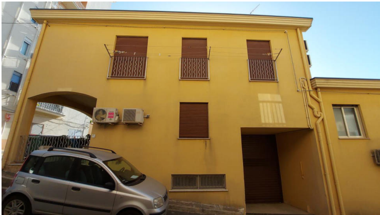
Foto 1 – prospetto principale su via Tesè
