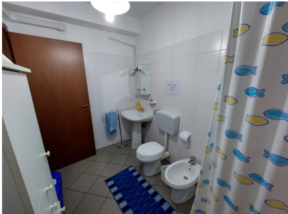
Foto 6 – w.c. da demolire
