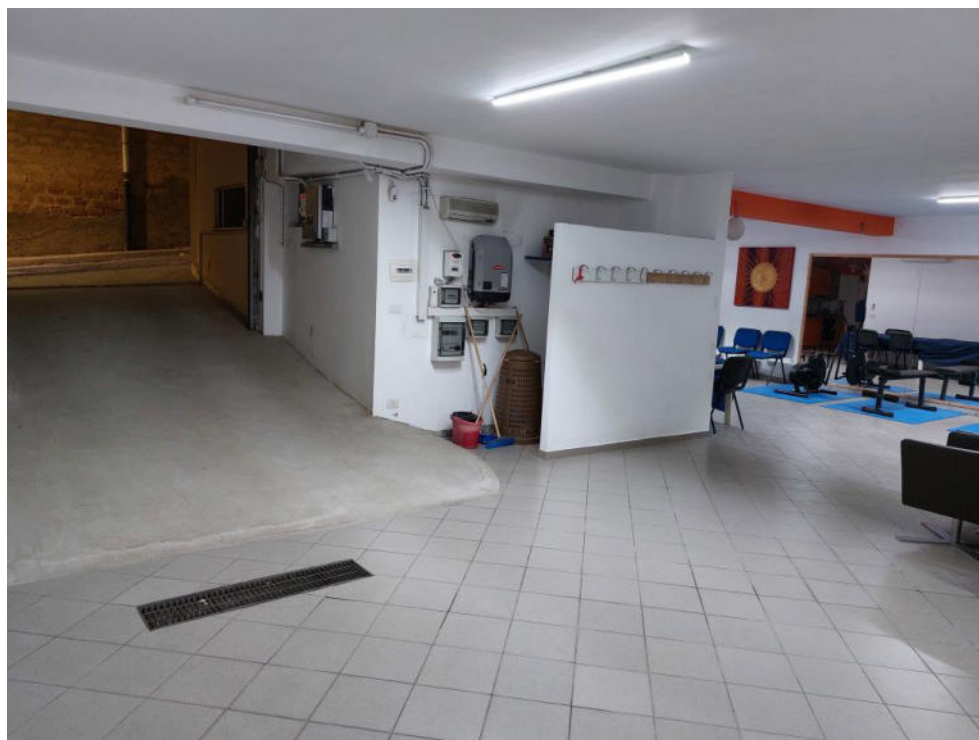
Foto 4 – area destinata a parcheggio e area impianti da rimuovere
