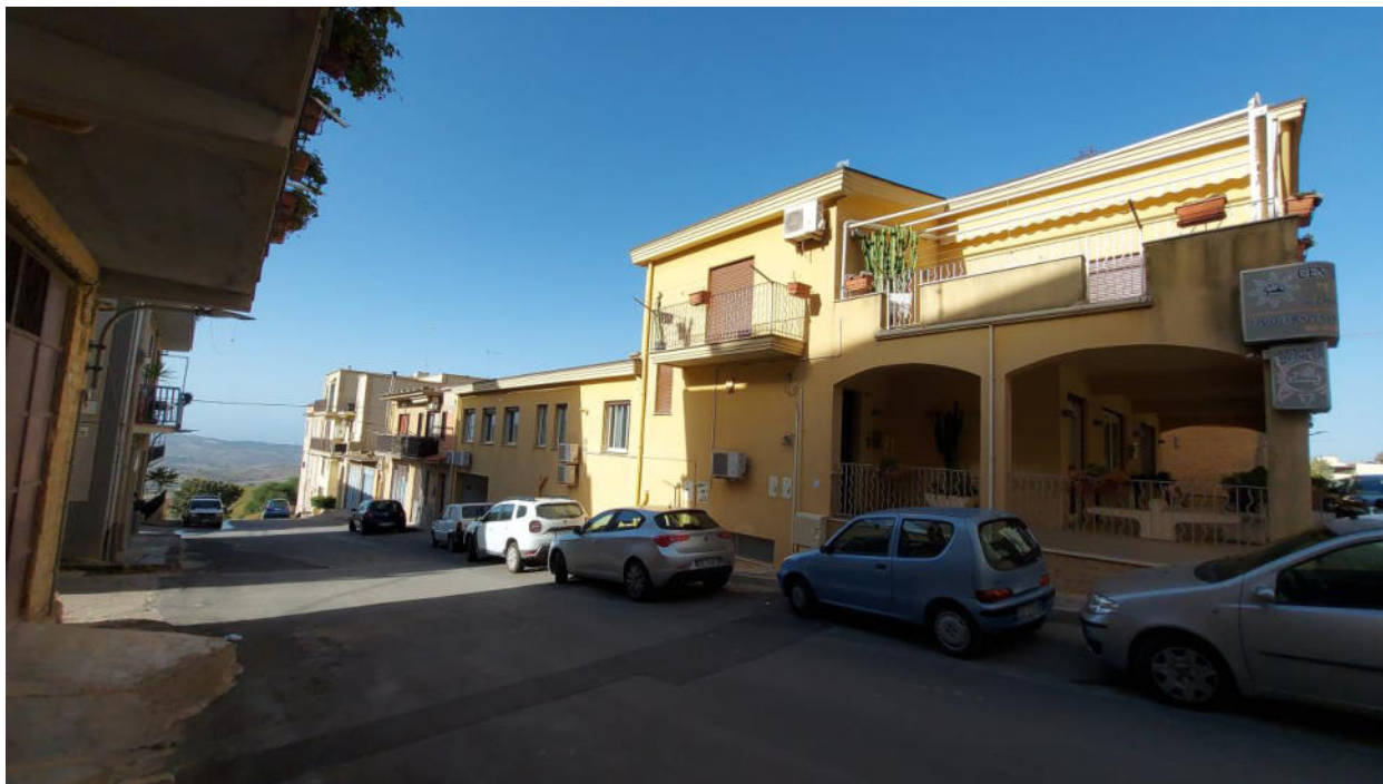
Foto 3 – prospetto laterale su via Colapuma
