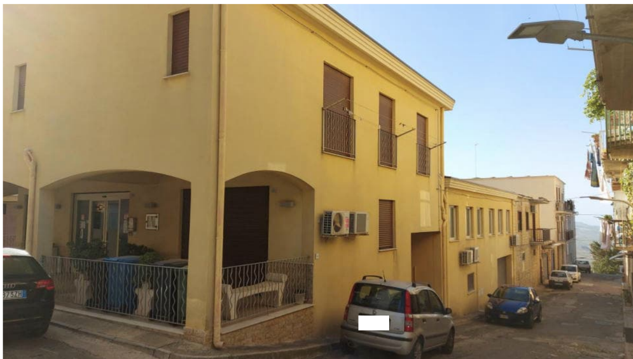
Foto 2 – prospetto fabbricato, angolo via Vittime del Terrorismo / via Tesè
