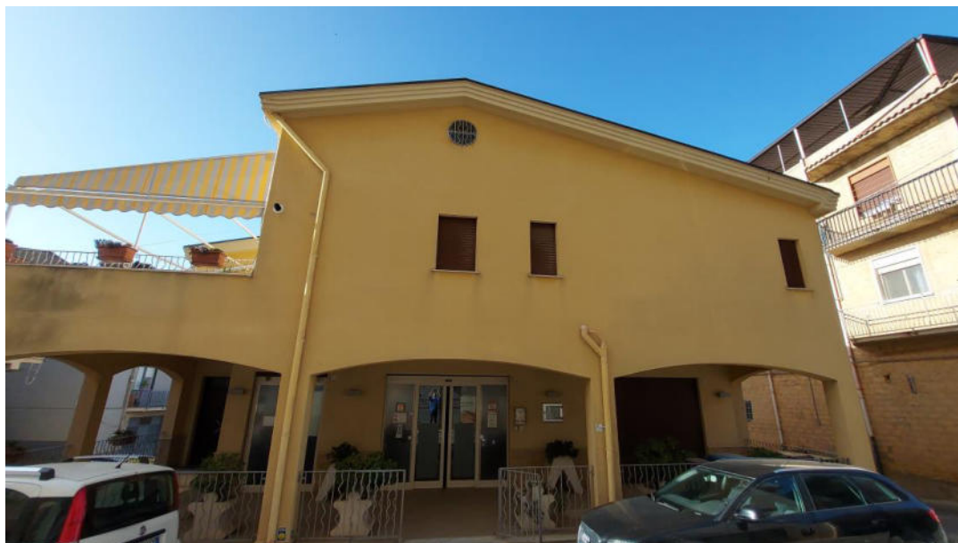
Foto 1 – prospetto principale su via Vittime del Terrorismo, 1A, 1B (ingresso principale) e 1C. con portico ad uso comune
