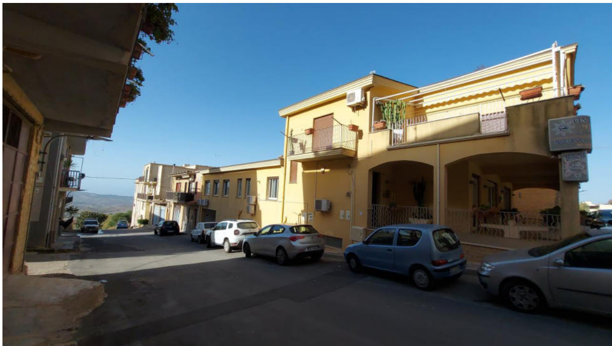
Foto 3 – prospetto laterale su via Colapuma
