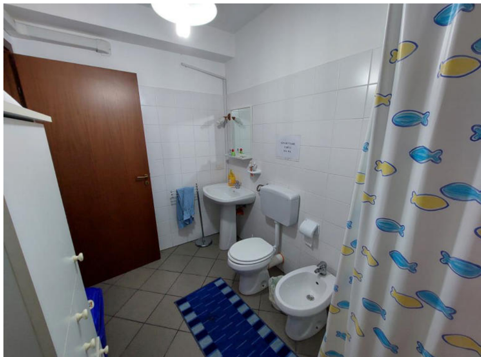
Foto 6 – w.c. da demolire
