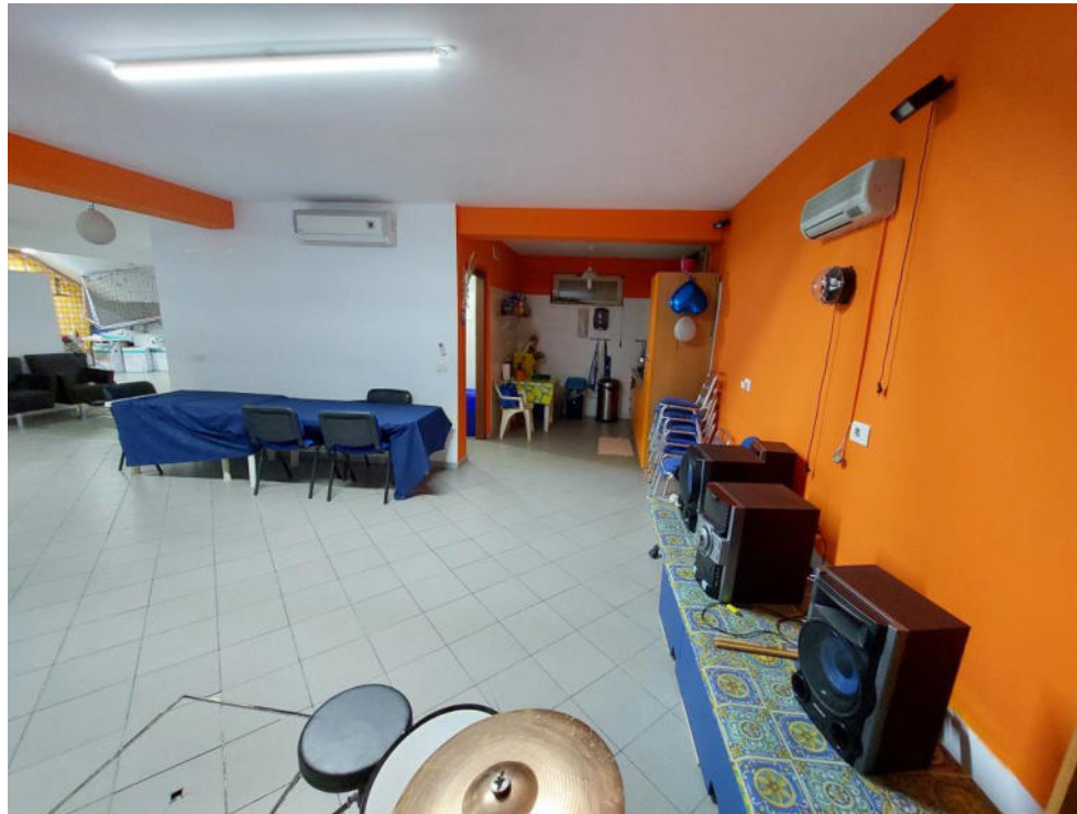
Foto 5 – cucinino da demolire
