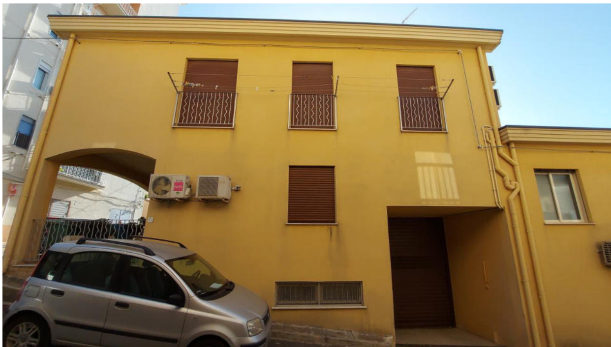
Foto 1 – prospetto principale su via Tesè
